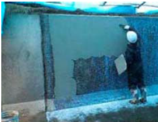
写真-5 セメントモルタル施工
