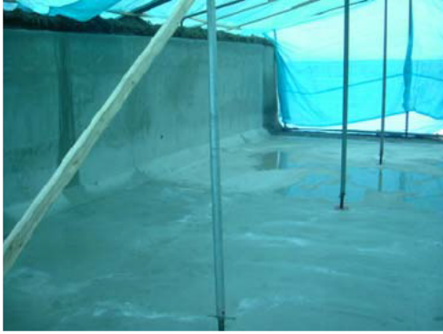
写真-7 施工後の状況
