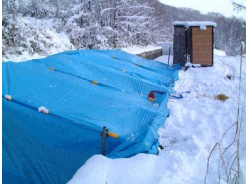
写真-3 養生仮設工
