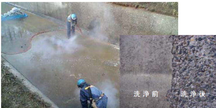
写真-2 劣化部除去工
