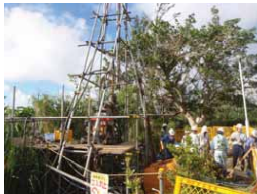
写真 2.4 定方位ボーリング実施状況
