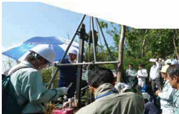
写真 2.5 モバイルボーリング実施状況
