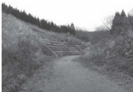
写真 2.7.1 アンカー工の全景
