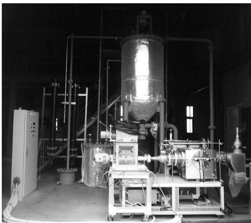
図-4.3.1 中能登町鹿島中部クリーンセンターに設置した実験機
