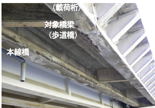
写真 4.1.3 撤去前の状況
