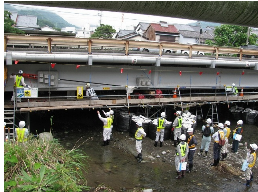
写真 6.3.1 外ケーブル緊張状況
