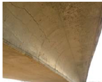
⑥B 橋 (1980 年建設, PC 中空床版橋)
