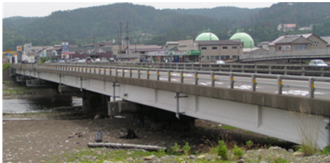
③ 中川橋側道橋 (1977 年建設, PC 床版桁橋)
