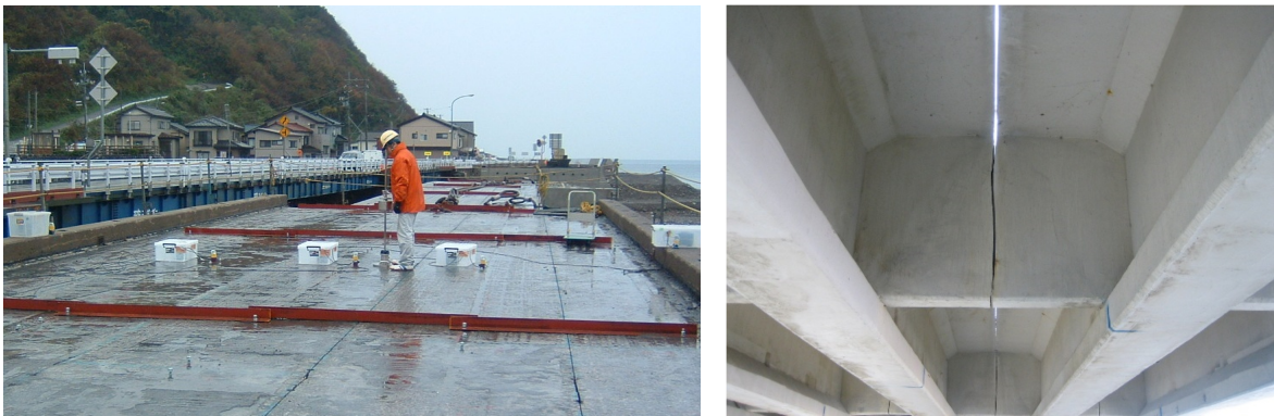
写真 6.1.3 主桁切断状態における振動測定の様子
