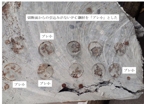
写真 6.3.3 G4 桁支間中央付近の撤去桁のひび割れ状況 (左) と切断面の状況 (右)
