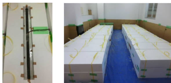
(A)打込み前の状況
