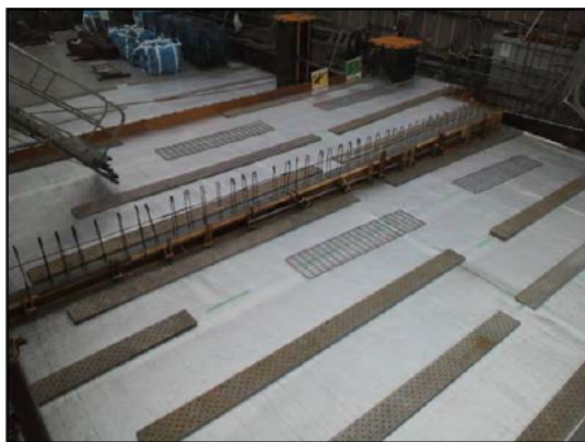
写真-7 養生マットを用いたスラブの養生
