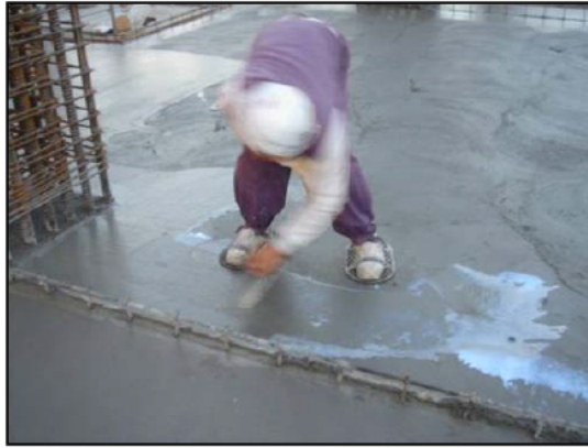
写真-5 膜養生剤の使用状況
