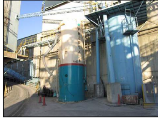
写真-4 新設サイロの設置
