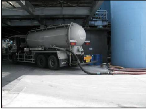
写真-3 セメントバラ車からの圧送
