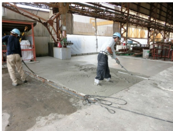
b) 締固め及び均しの状況
