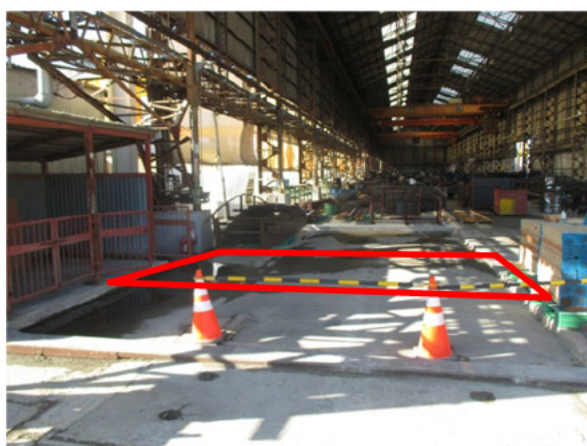
写真ー1 施工前の状況
