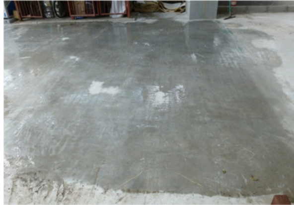
写真-3 養生完了後の状況
