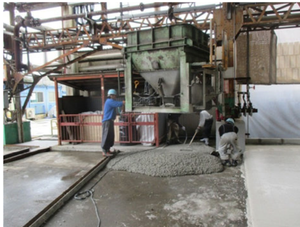
a) バケットによる打込み状況
