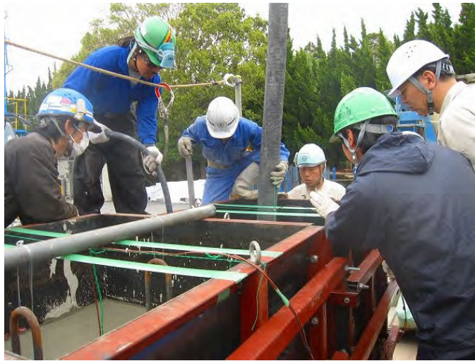
写真-8 コンクリートポンプ車による打込み状況
