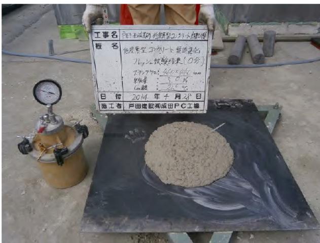
写真-2 コンクリートのフレッシュ性状
