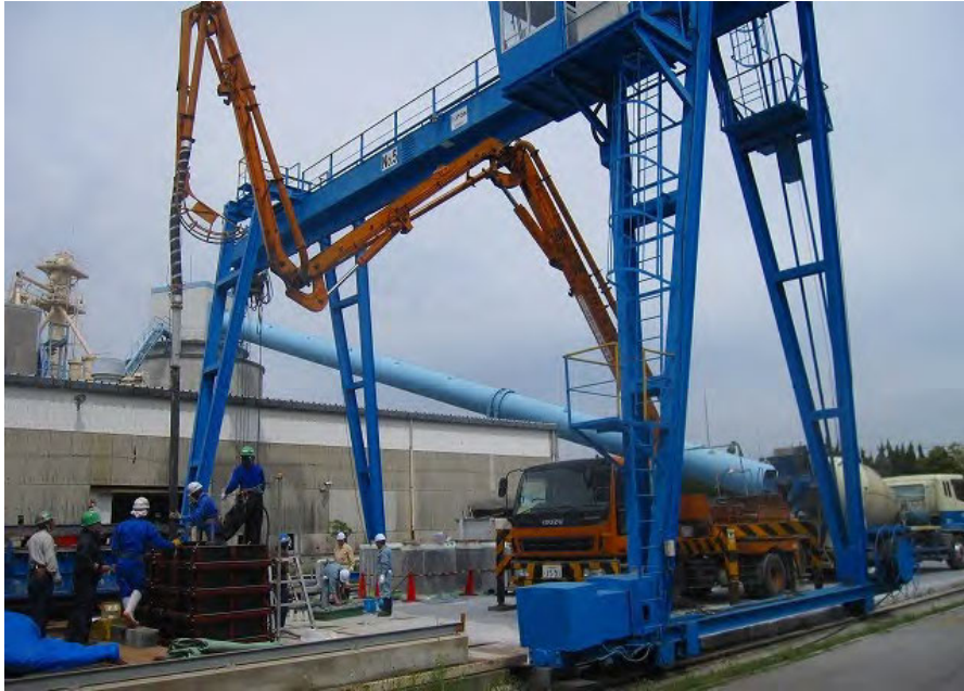
写真-5 コンクリートの打込み状況
