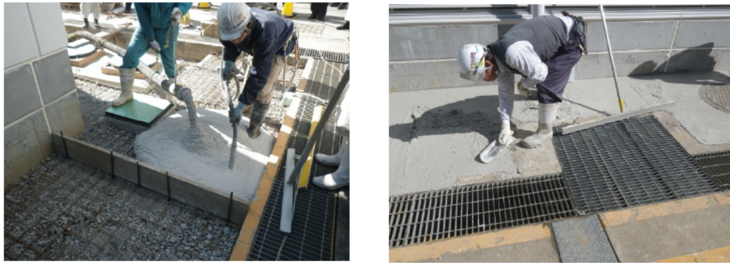
a) 打込みの状況
