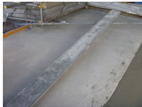
b) 仕上げ後の状況
