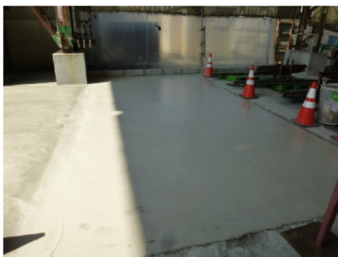
写真-9 養生終了後の状況
