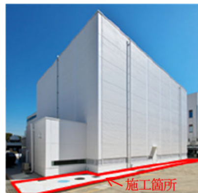
b) 施工完了
