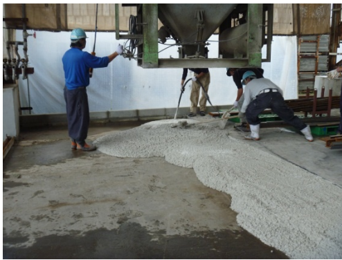
a) バケットによる打込み状況
