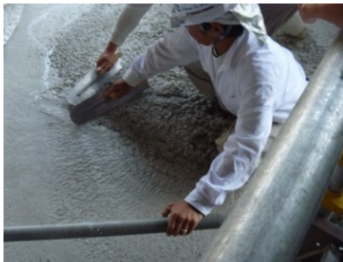
a) 均しの状況
