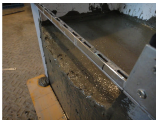
写真 4.5.1.2 エッジスランプ, オーバーフローの状況
