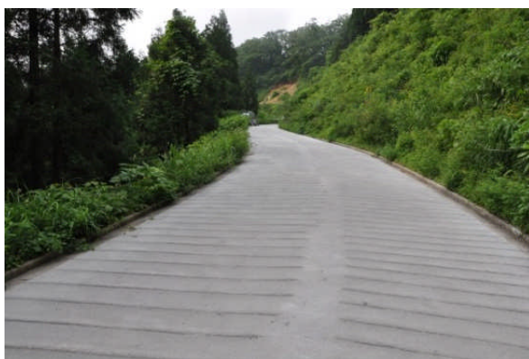
写真 7.4.2.1 試験施工現場の様子
