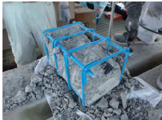
写真-4.5.4 腐食状況 (試験体 B092)
