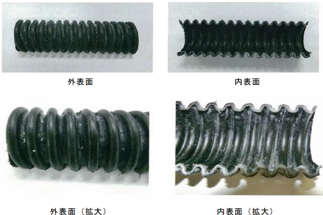
写真-4.10.2 30年暴露後のPEシースの外観状況
