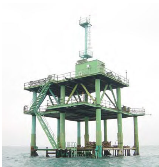
写真-1.4.1 海洋技術総合研究施設
