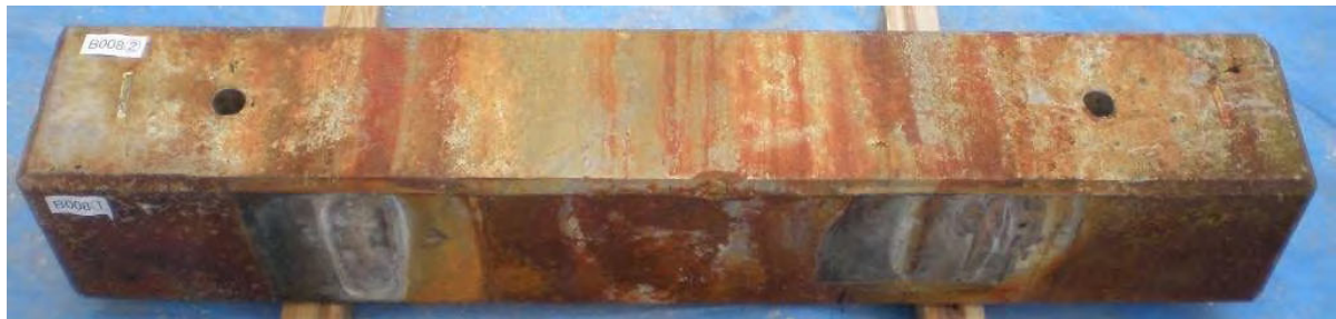
(a) コンクリート
