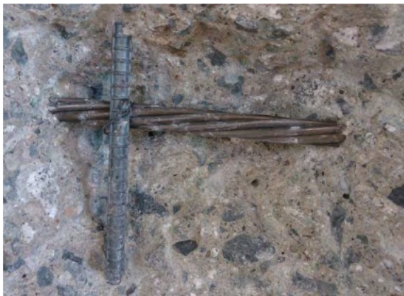
写真-4.5.3 腐食状況 (試験体 C029)
