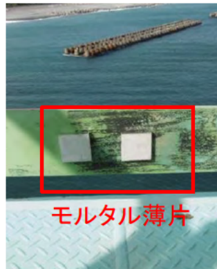
b) 観測塔上段南面 (高欄部)
