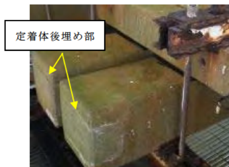
写真-4.1.5 ポストテンション定着体後埋め部状況
