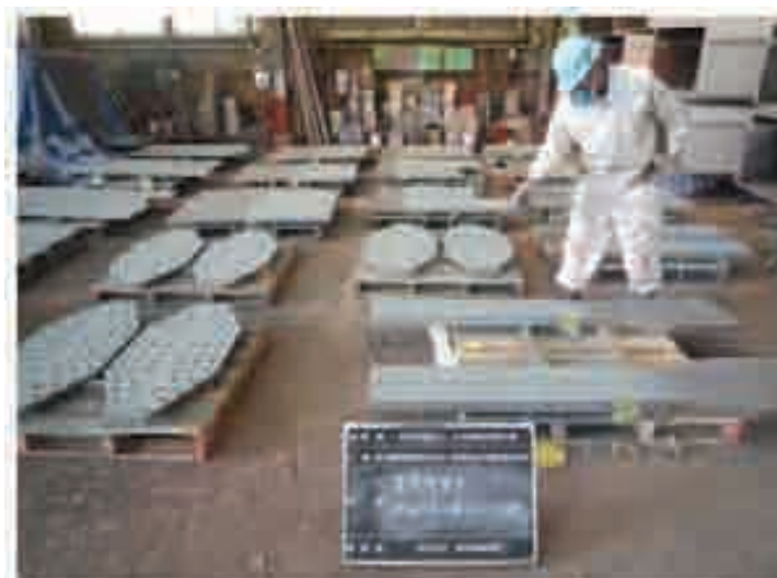
写真- 1.1.1 無機ジンクリッチペイントの塗布状況
