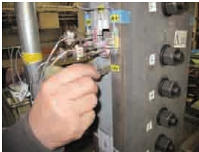
写真- 2.3.2 肌すき量の計測状況
