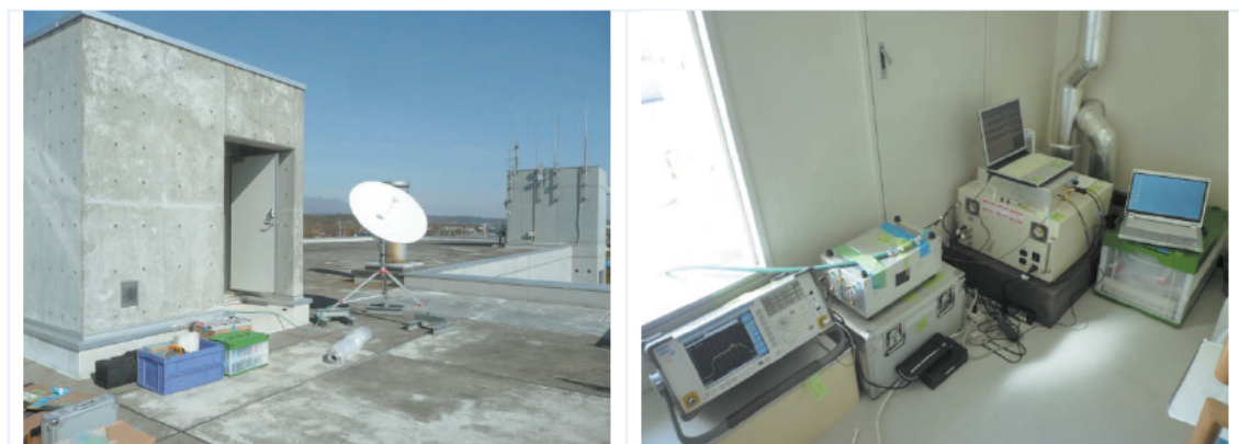
図 23 樽前山火山対策防災拠点施設屋上 基地局設営
