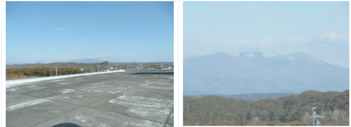
図 21 樽前山火山対策防災拠点施設屋上 樽前山撮影
