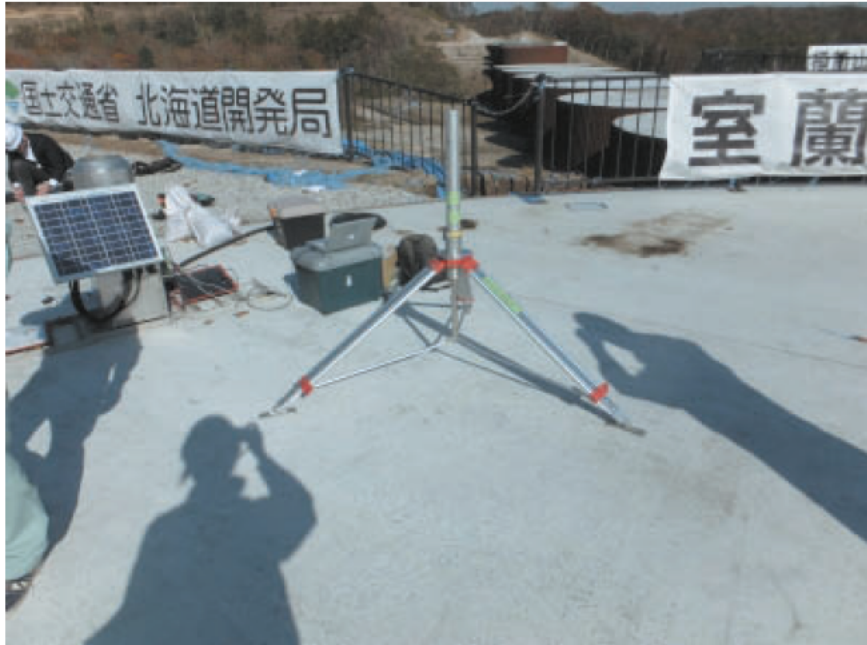
図 30 超小型通信端末固定用三脚の設置作業状況
