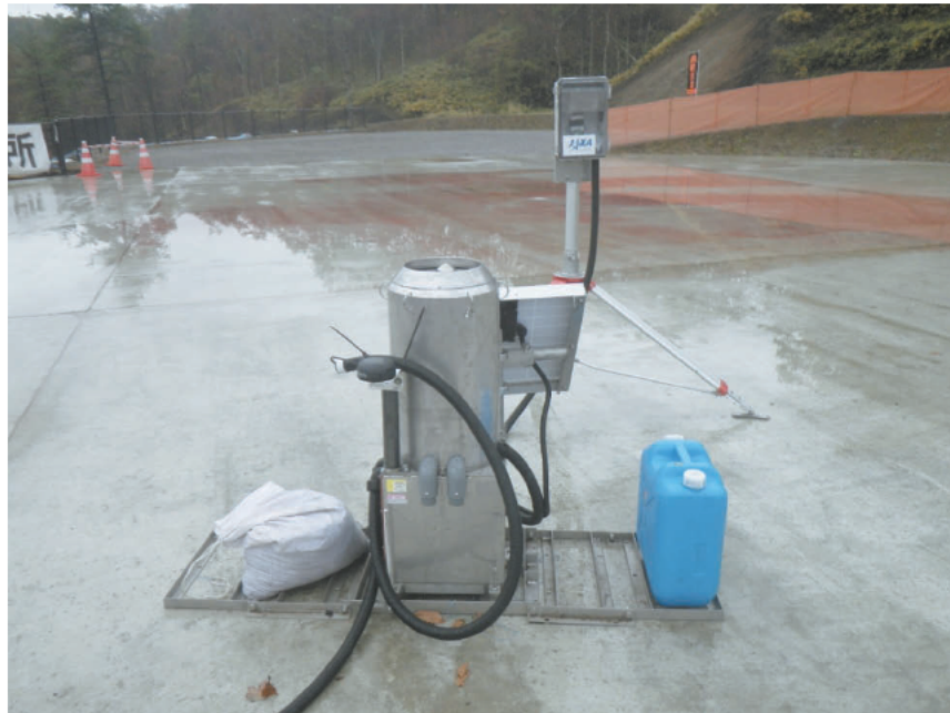
図 34 設置完了状況 (近景)
