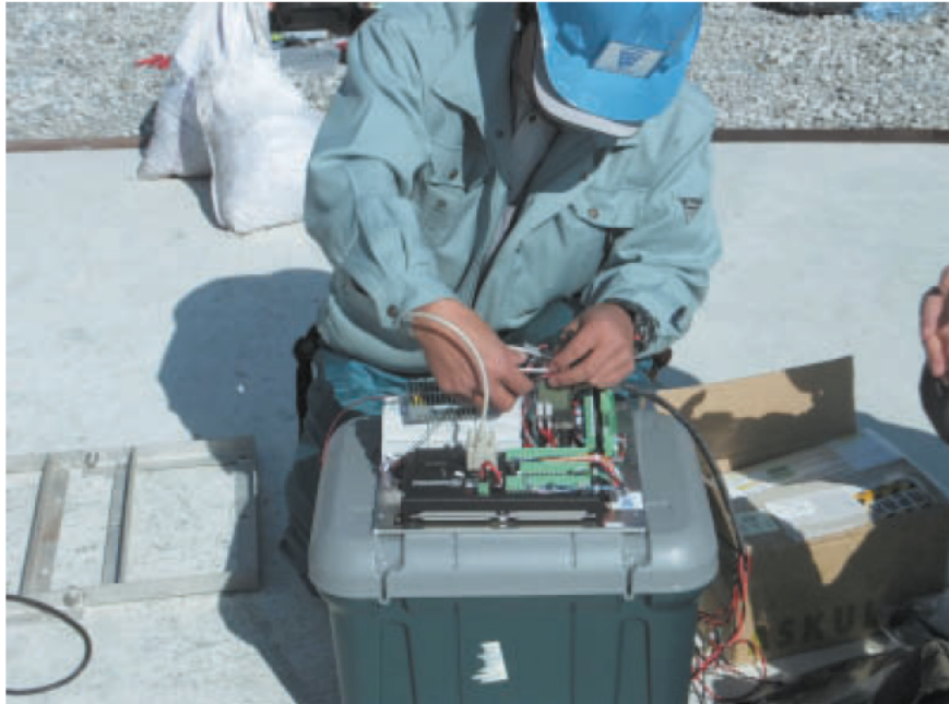
図 28 配線作業状況
