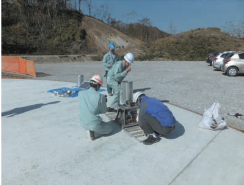
図 26 組み立て作業状況 (その1)
