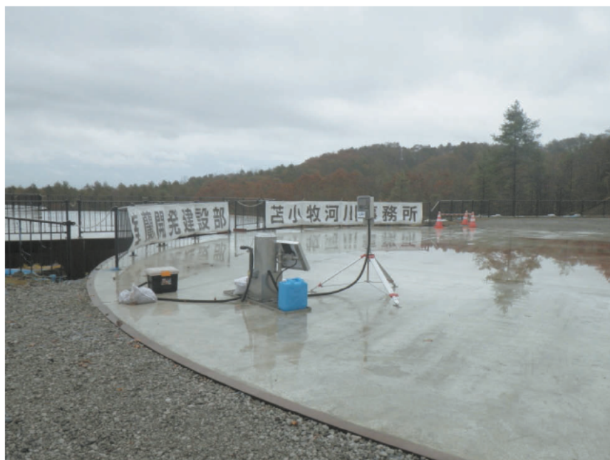
図 35 設置完了状況 (遠景)
