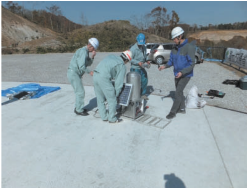
図 27 組み立て作業状況 (その2)
