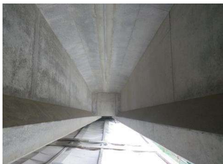
付写真 7.3 床版下面
