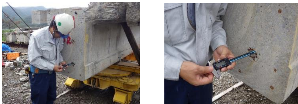
付写真 7.8 PC 鋼材引き込み量調査状況
