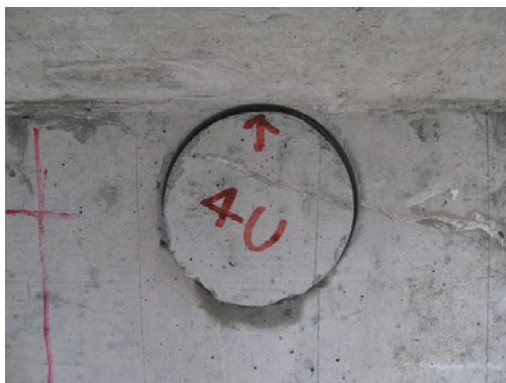
(a) ひび割れ部削孔状況
