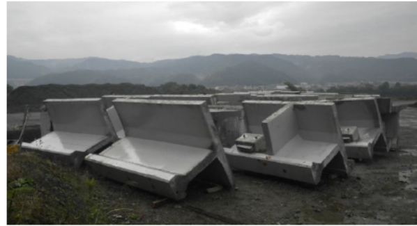
付写真 6.4 撤去桁の全景
