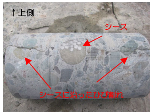
(b) 部材内部のひび割れ状況
