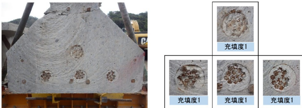
付写真 7.4 G5主桁 支間中央部 (切断面 4)
