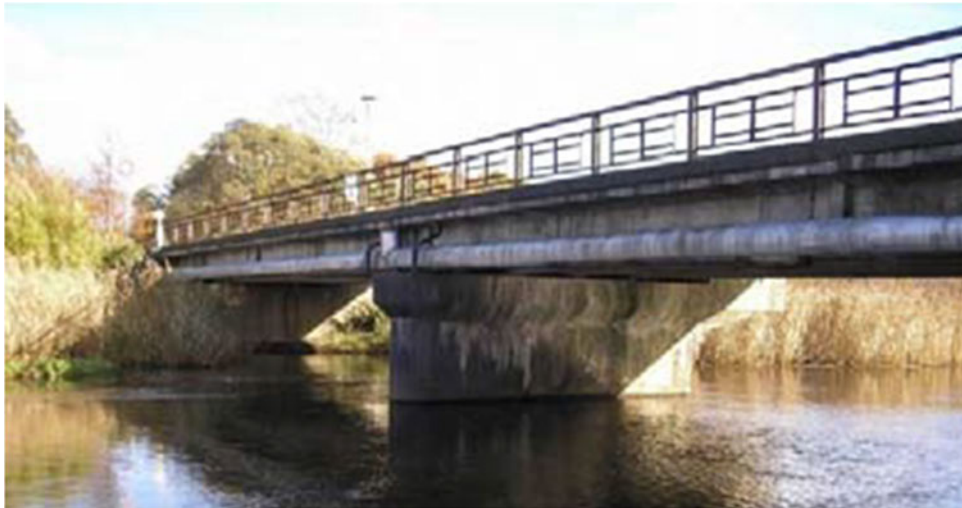
付写真 4.1 植苗橋全景（撤去前）
