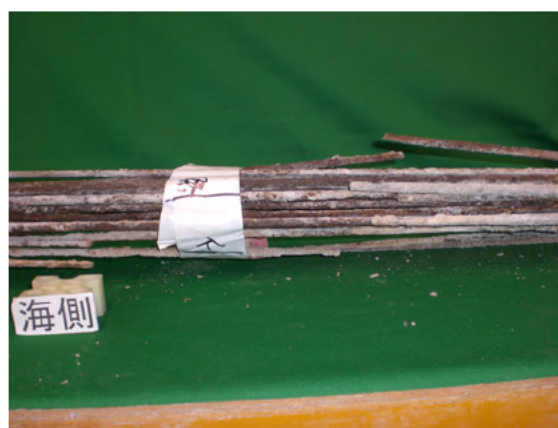
写真3.2.6 C3ケーブル破断状況
