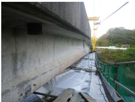
付写真 7.2 主桁側面
