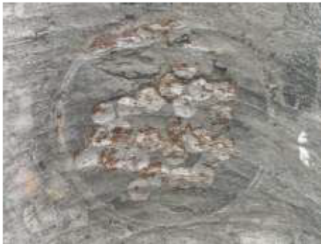
付写真3.6 グラウト充填度1 (第1径間G2桁⑤)
