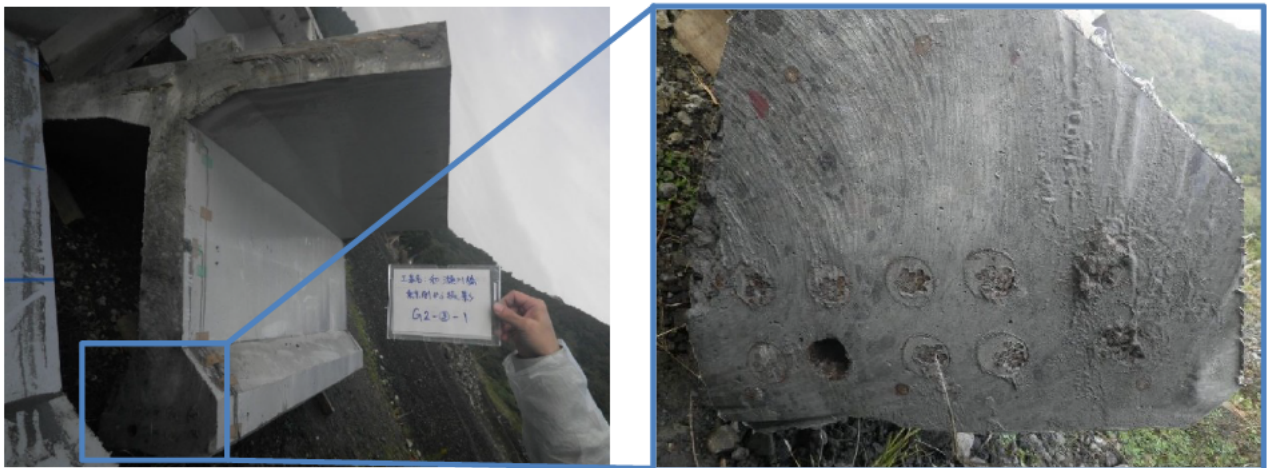
付写真 6.6 G3桁の支間中央 5-5 断面のグラウト充填状況
