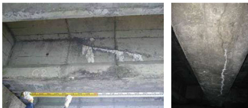
写真4.1.2 撤去前の外観調査結果
