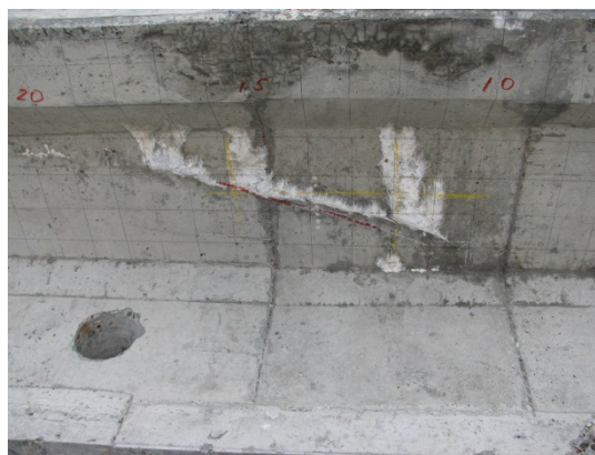
付写真 4.5 外観調査状況
