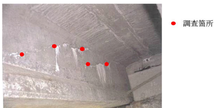
図 5.5.1 グラウト充填調査箇所の絞り込み
