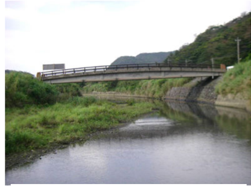
付写真 7.1 橋梁全景
