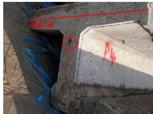
(b) 床版天端から約 30cm 下にある未充填箇所 (第 5 径間 G1 桁 BL1 A2 側断面)
