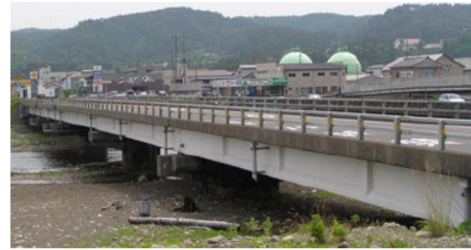
付写真 3.1 橋梁全景
