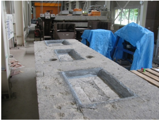
(a) 水張り前
