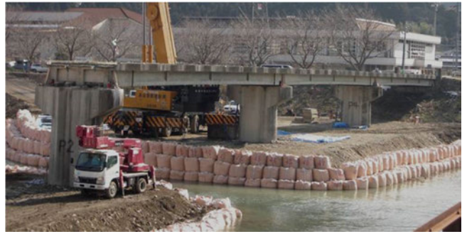
付写真 1.1 佐野橋全景（撤去時）
