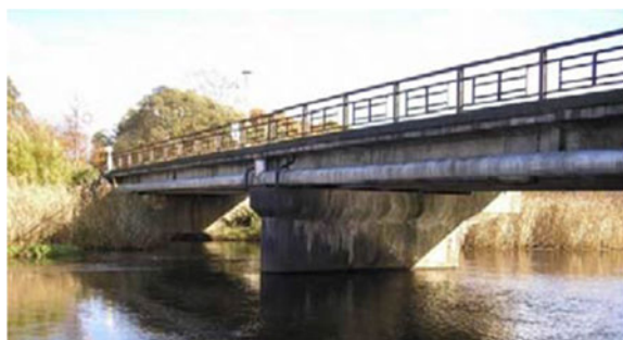
写真4.1.1 橋梁全景(上流側より撮影)
