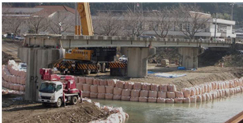
写真 3.1.1 橋梁全景（撤去時）
