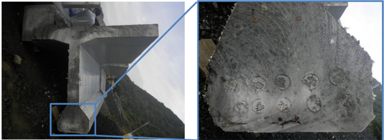
付写真 6.5 G4桁の支間中央 5-5 断面のグラウト充填状況
