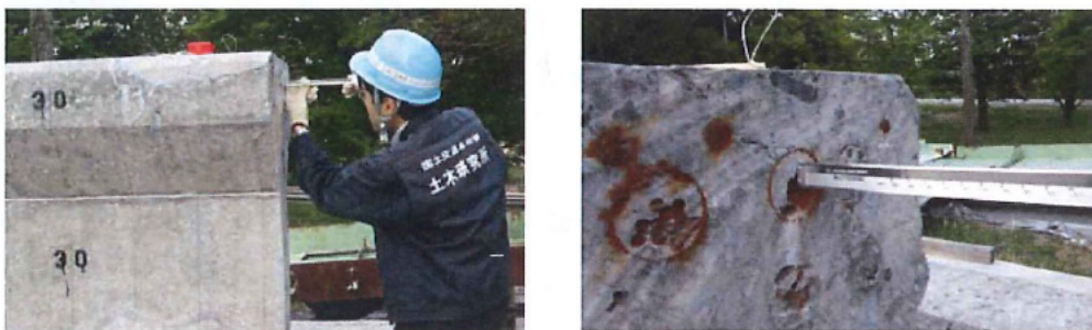
付写真 6.3 PC 鋼材引込量の測定状況
