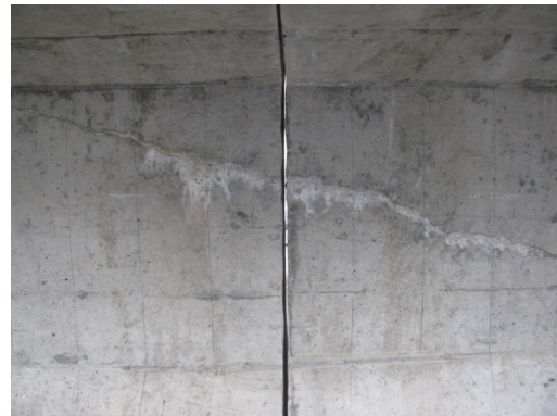
(b) ひび割れ部切断状況
