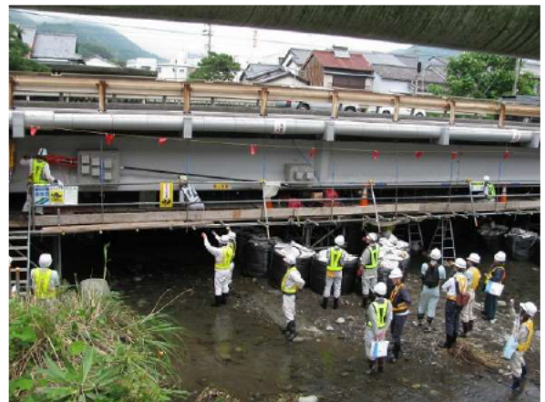
付写真 6.1 外ケーブル緊張状況
