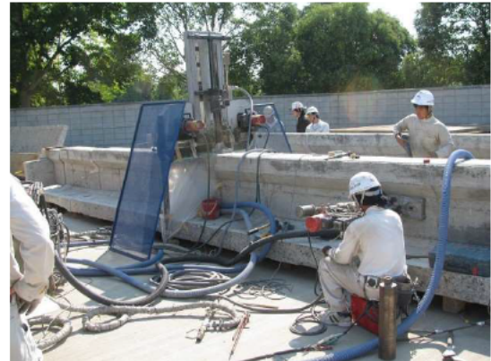
付写真 4.6 切断・コア削孔調査
