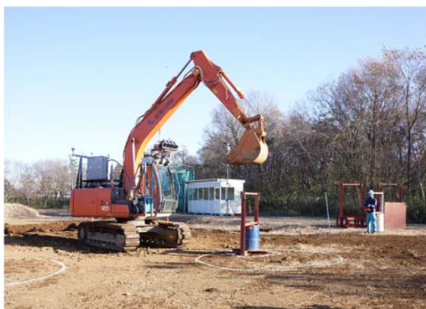
Fig. B-16 やぐら下からの遠隔操作状況
