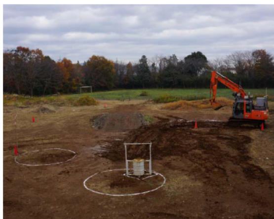
Fig. B-5 実験フィールド全景
