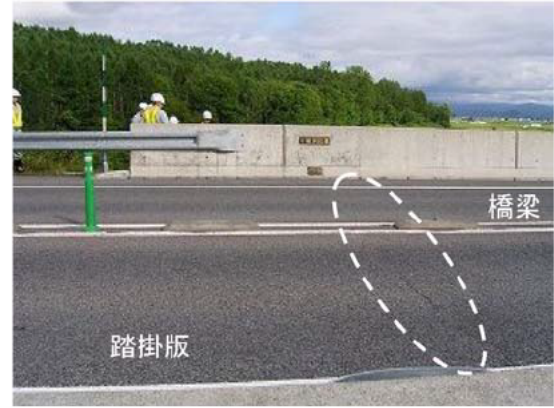
写真 1.1.1 橋台背面の舗装のひび割れ状況
