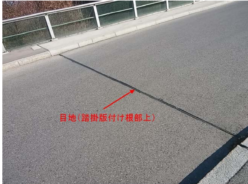
写真 6.3.2 ドイツでの踏掛版付け根部の目地設置例
