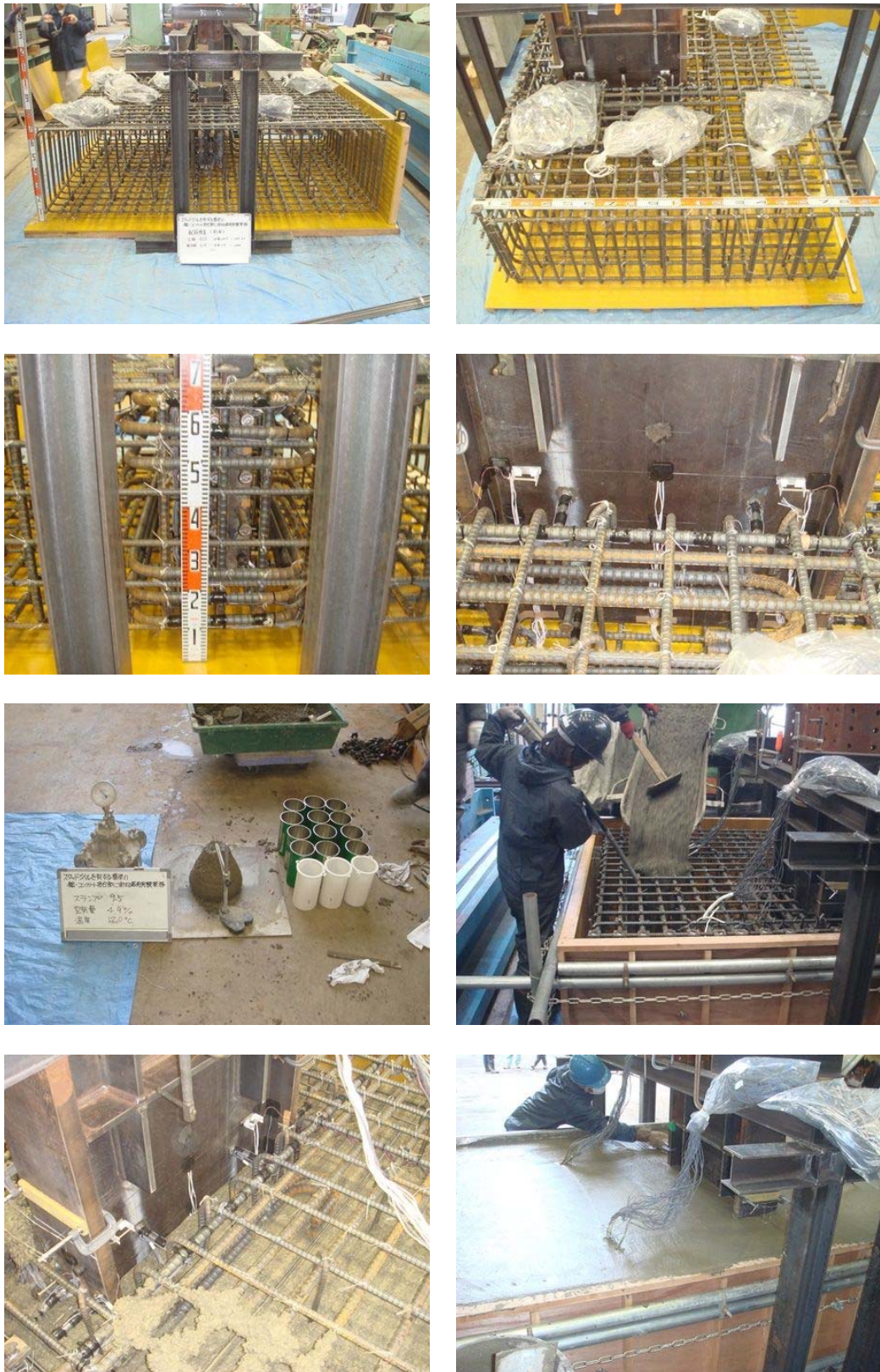
写真 4.2.2 配筋検査及び打設状況
