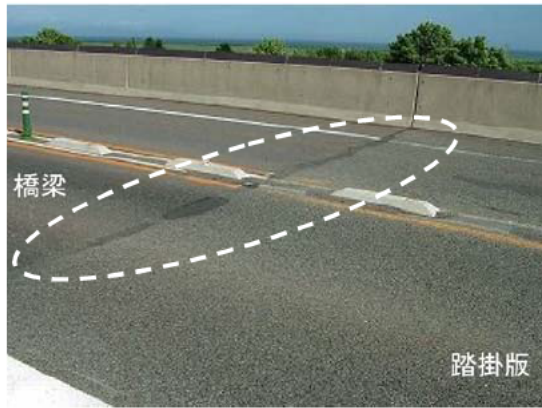
写真 1.1.1 橋台背面の舗装のひび割れ状況
