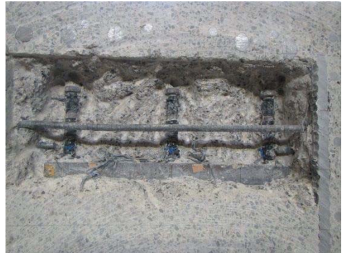
(b) 鋼桁上フランジ部スタッド
