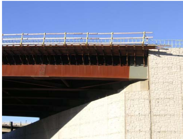
写真 2.3.2 耐候性鋼材の桁端部塗装例
