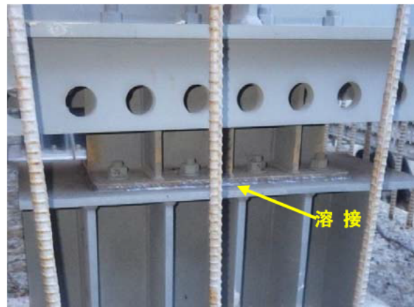
写真 3.4.3 溶接による固定
