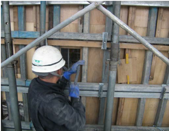
写真 6.1.5 打設用開口窓からの締固め状況 1)
