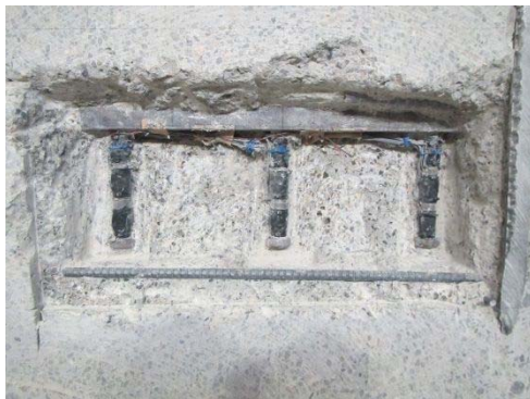
(c) 鋼桁下フランジ部スタッド
