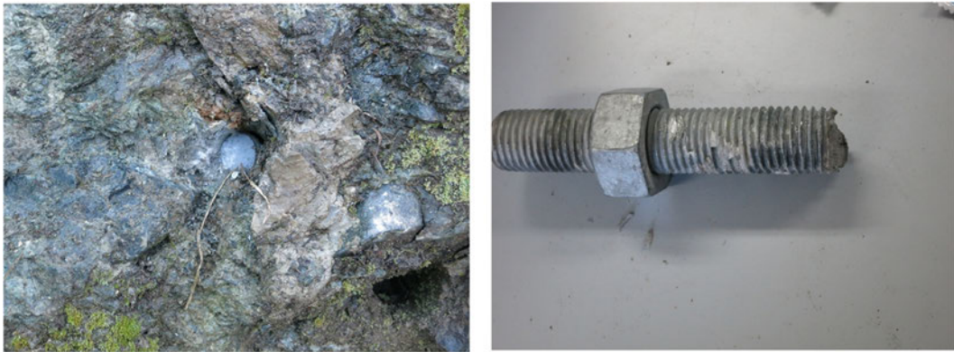
写真2.2.4 アンカーボルトの破断
