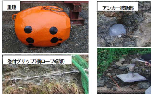
写真 2.3.2 重錘・巻付グリップ・アンカー破断状況
