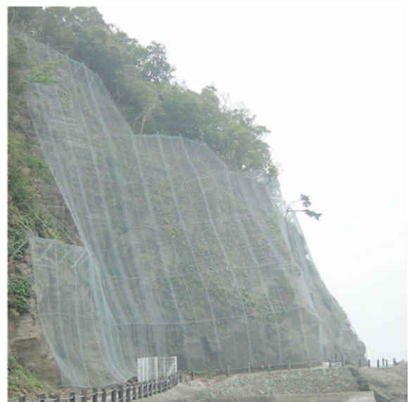
写真 1.2.1 従来型ポケット式落石防護網の例
