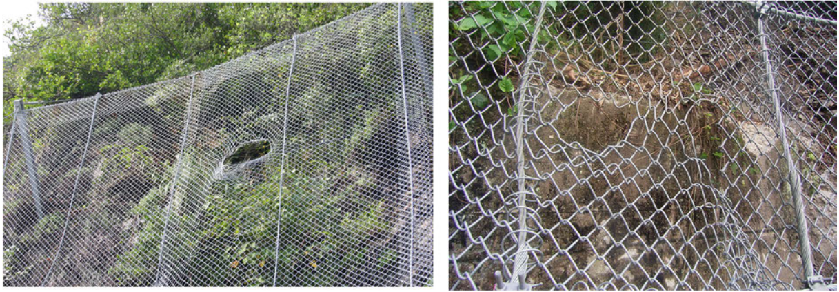
写真 2.2.1 金網の破網
