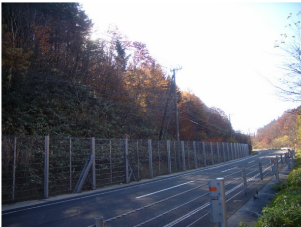
写真 1.2.2 従来型落石防護柵の例
