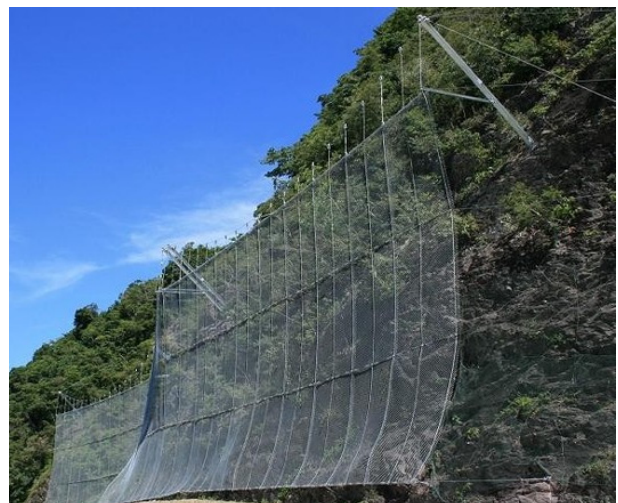
写真 1.2.4 高エネルギー吸収型落石防護網の例
