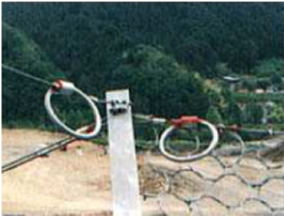
写真3.3.6 鋼材摩擦変形型 [ブレーキリング] (柔構造物工法研究会 HP より)
