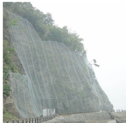
写真 2.1.1 ポケット式落石防護網の例
