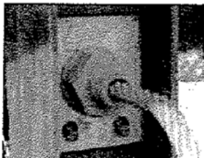
写真3.3.8 摺動摩擦型 [索端金具タイプ]
