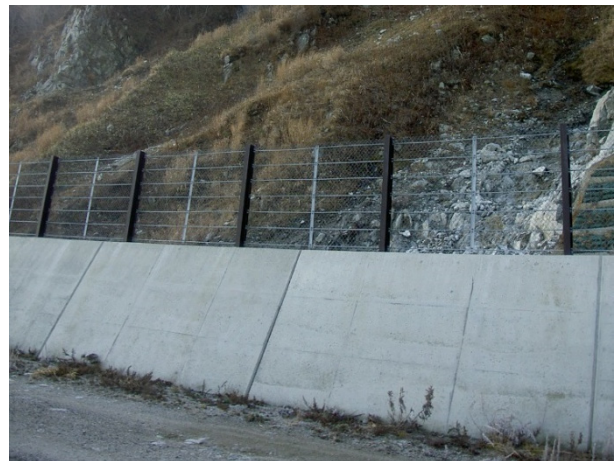
写真 1.2.3 従来型落石防護柵の例
