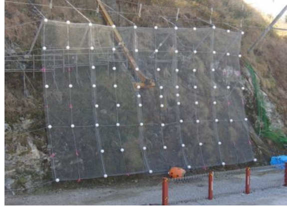
写真3.4.8 金網へのターゲットマーカ― 設置状況
