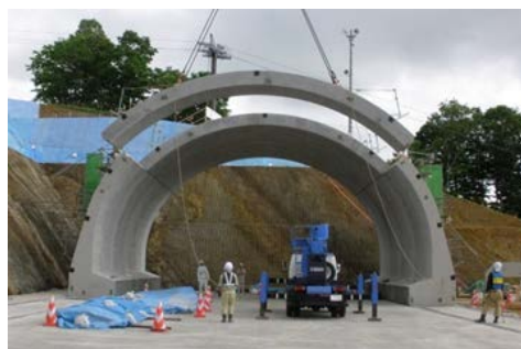
(b) 施工写真
