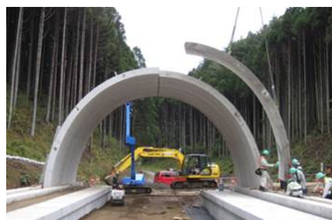
(b) 施工写真
