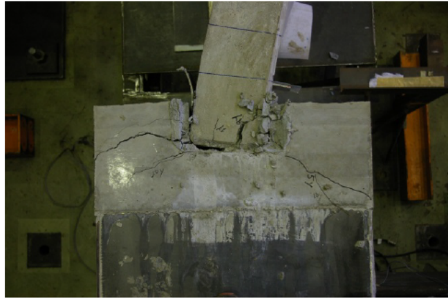
写真-3.3.4 基礎部終局状況 基礎部コンクリートのひび割れを確認
