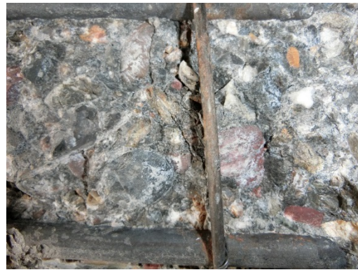
(d) 2300mm 付近-スパイラル鉄筋
