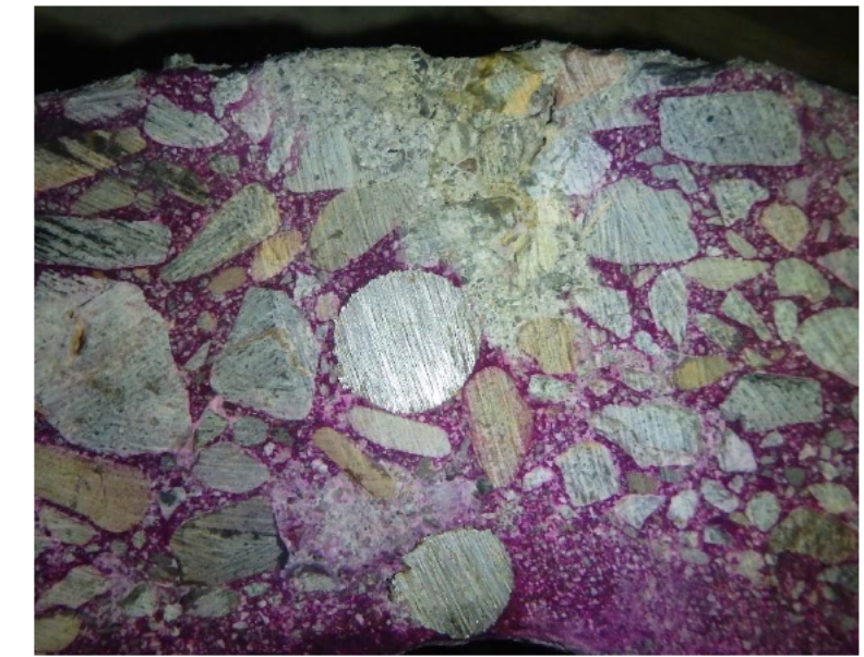
写真 4.3.14 中性化拡大：No. 2-切断位置④（採用；下側）
