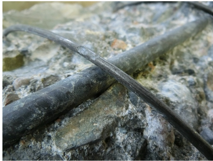
(a) 軸方向鉄筋 No.5-1700mm 付近
