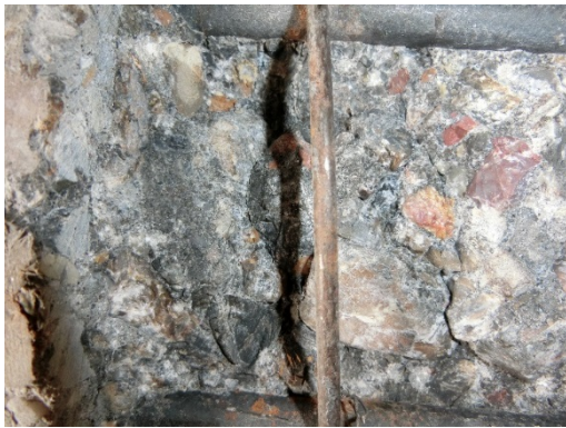
(c) 2200mm 付近-スパイラル鉄筋
