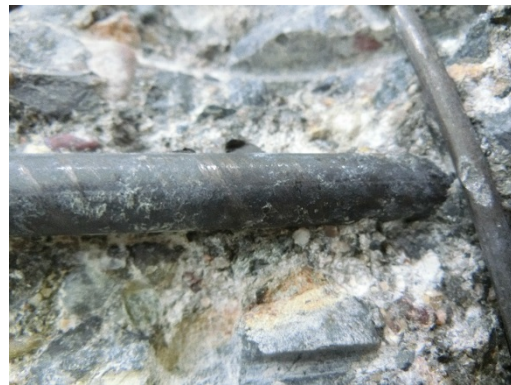
(c) 軸方向鉄筋 No.5-1800mm 付近
