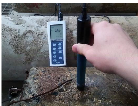
写真 4. 3. 1 自然電位測定状況
