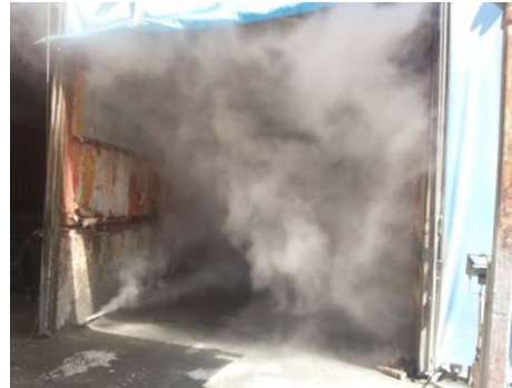
写真-6.4 蒸気養生状況
