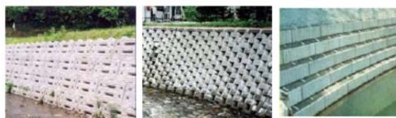
写真-6.27 緑化ブロック
