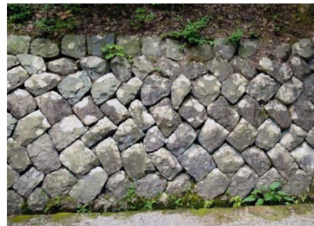
写真-3.5 自然石護岸
