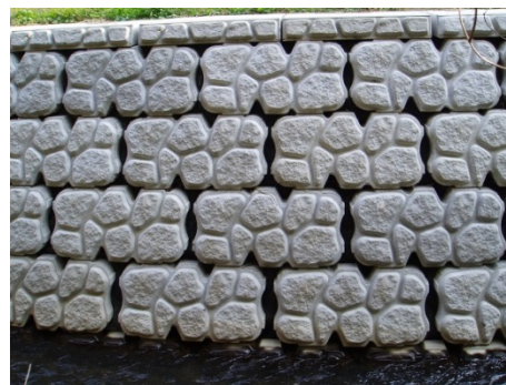
写真-3.13 ブロック護岸
