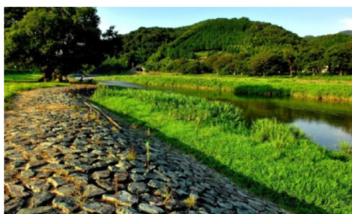
写真-3.20 低水護岸の天端をラウンディングした事例（小田川(愛媛県)）
