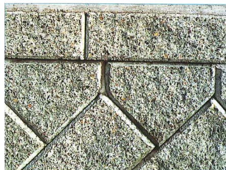
写真-3.17 半割りした表面の コンクリートブロック
