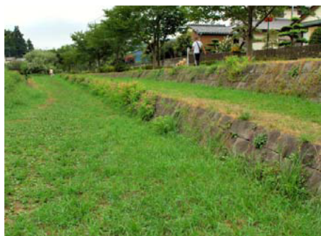
写真-3.23 護岸を階層に分けることにより、一層あたりの面積が小さくなる（まとまりを小さく見せる）。また、水際、天端に植生があり、護岸の見えが小さくなっている
