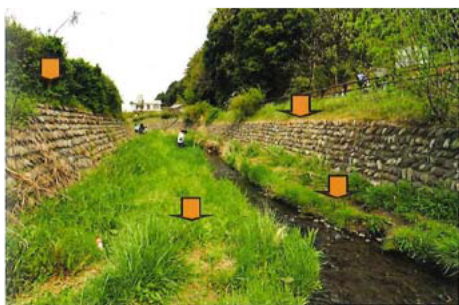
写真-3.21 天端と水際部を土（植生）で 柔らかく仕上げた事例
