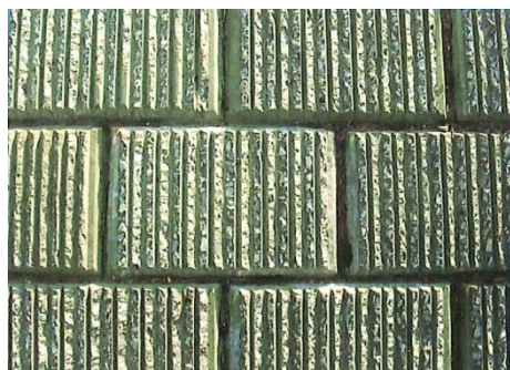
写真-3.16 表面を線状に掻き、 骨材の表情を出したブロック
