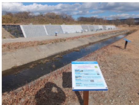
写真-4.1 概略説明用パネルの設置
