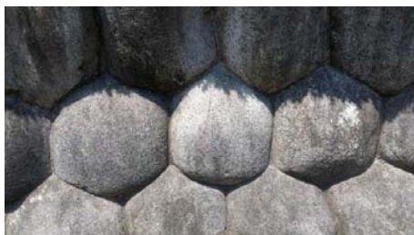
写真-3.7 宅地や寺社に用いられるが河川ではあまり用いられない六角形を基調とした形状・積み方
