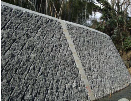
写真-3.18 現場打ちで滑面に仕上げられた 天端コンクリート
