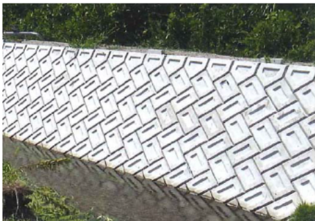
写真-3.4 滑面のコンクリート護岸
