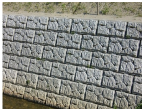
写真-3.9 ブロック護岸
