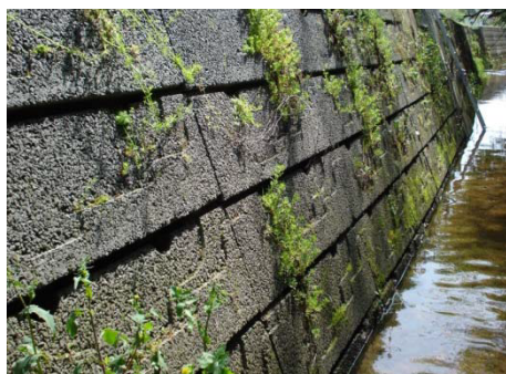
写真-3.14 ポーラスコンクリートを使用
