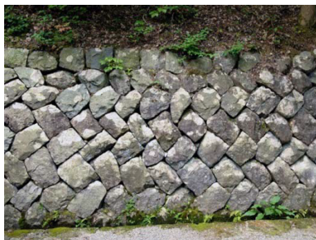
写真-3.12 石積み護岸
