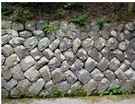
写真-3.8 石積み護岸
