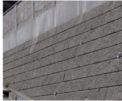
写真-3.19 水抜きパイプが目立つ護岸
