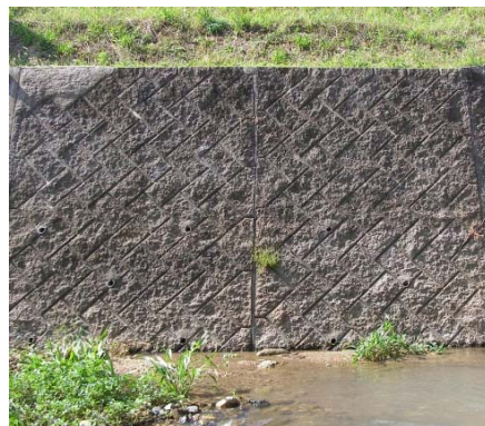
写真-3.3 護岸が周囲に馴染んでいる例 (護岸の明度 3.0 程度)
