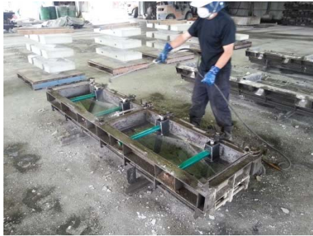
写真-6.3 剥離剤塗布状況
