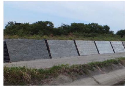
写真-6.12 景観実験護岸
