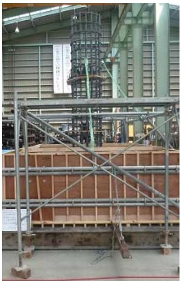
コンクリート打設前型枠状況(フック式)
