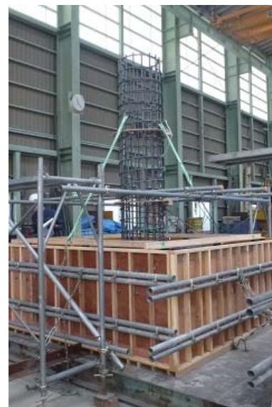
コンクリート打設前型枠状況(スパイラル式)
