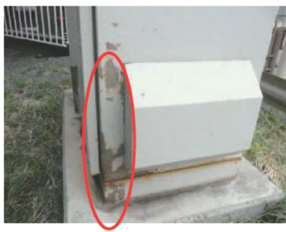
塗装劣化、腐食部のタッチアップ
