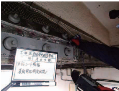
写真 5.5 既設防食板周囲 ON 電位計測
