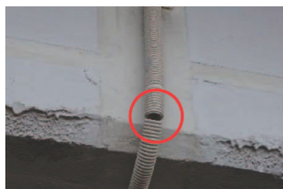
脱落部の補修, 割れた配管材の交換
