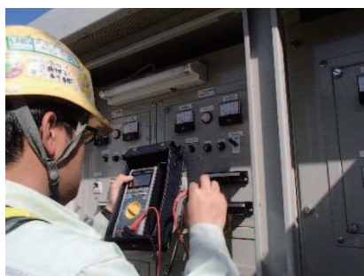
鋼材電位の確認
