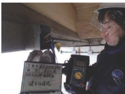
写真 4.3 電位値確認状況
