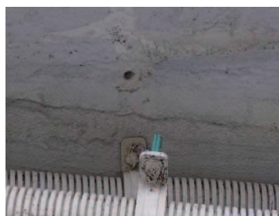
写真 1.8 固定ビスの抜け落ち
