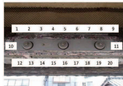
図5.2 海側防食板測定位置(20点)
