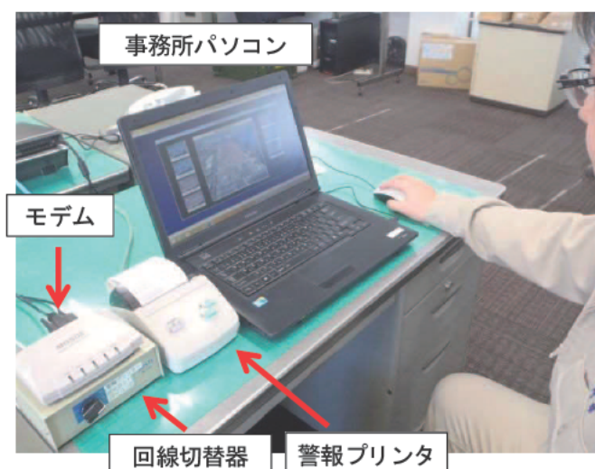
写真-2 管理事務所側の外観
