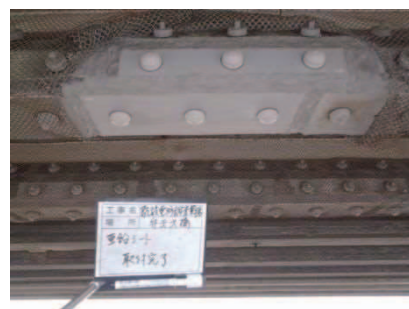
写真 5.4 代替防食板設置完了
