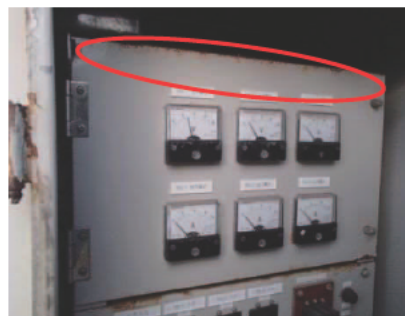
塗装劣化、腐食部のタッチアップ
