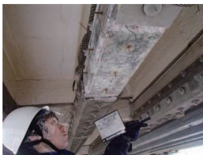
写真 5.3 コンクリート表面確認
