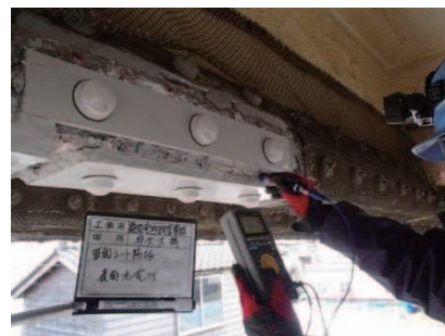
写真 5.6 代替防食板周囲 ON 電位計測
