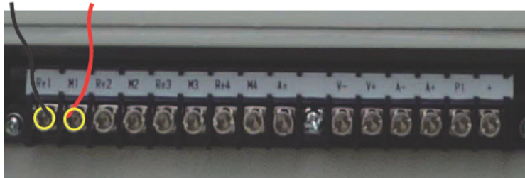
[ 鉄筋電位の測定 ]
