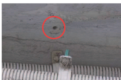
脱落部の補修, 割れた配管材の交換
