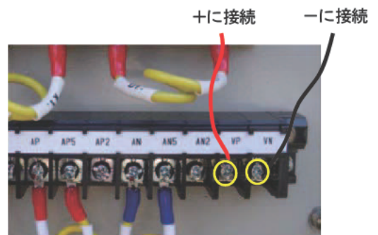
[ 通電電圧の測定 ]
