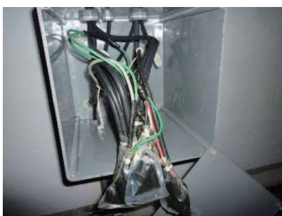
プルボックス内結線部の確認
