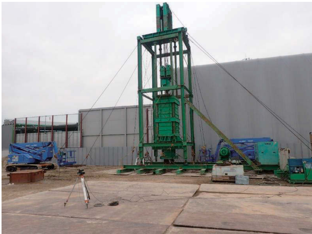
写参 8.3.2 急速載荷試験状況
