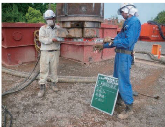
(a) 拡径式ビット確認
