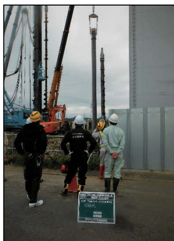
(c) 杭建込み状況・鉛直確認
