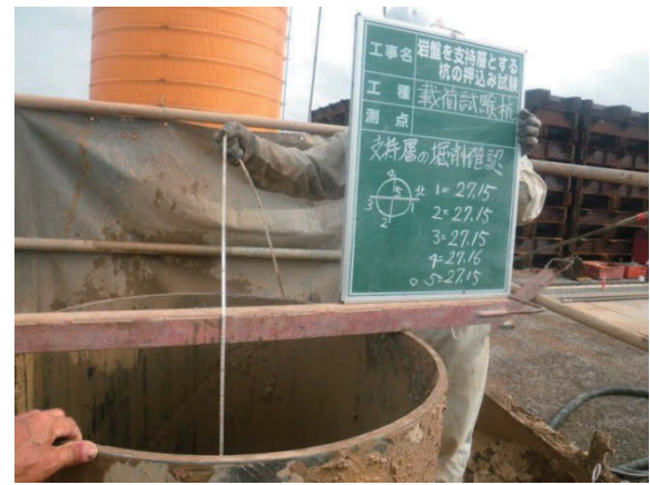
(f) 重錘による孔底確認
