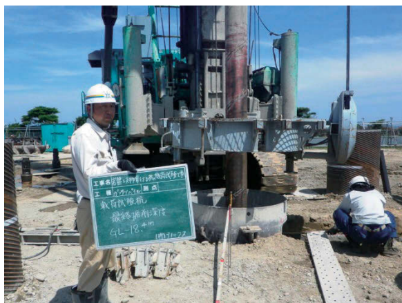
(a) GL-18.4m 掘削完了
