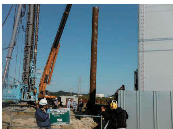
(c) 杭建込み状況・鉛直確認
