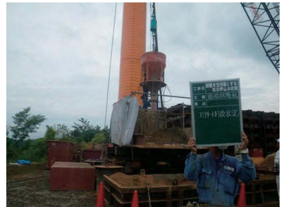
(h) コンクリート打設
