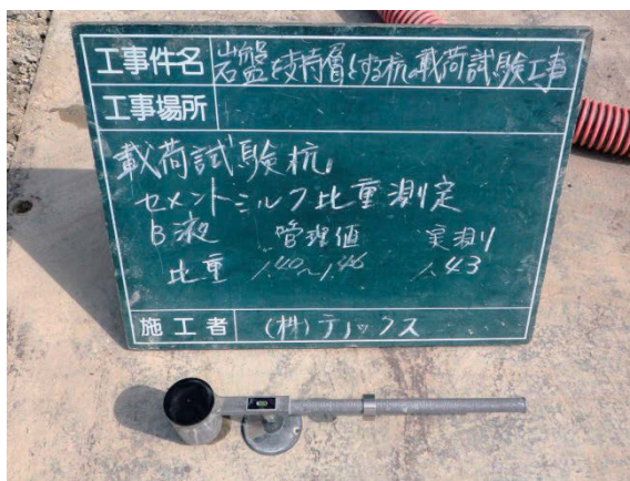
(f) 杭先端固化体部のセメントミルク比重測定
