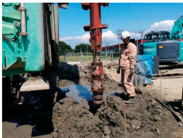
(f) 根固部での未固結採取器
