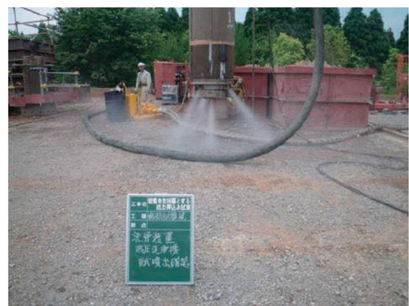
(b) エア、水の試噴射
