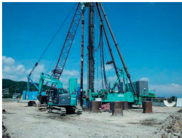
(b) 掘削状況
