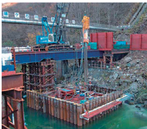
図参 7.3.2 クレーンによる吊り下げ施工 2)
