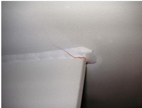
写真 - 2.2.1 垂直補剛材側を起点とするき裂
