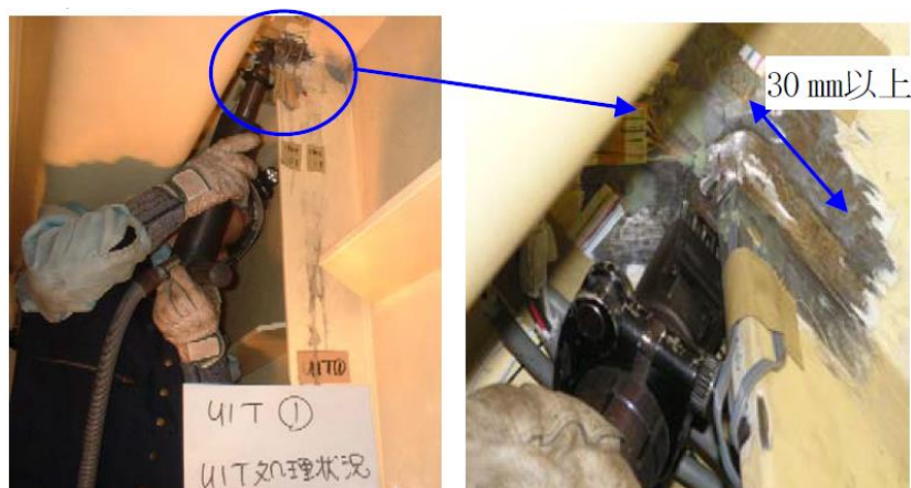
図 - 2.3.8 主桁垂直補剛材上端部を対象とした UIT の施工事例 2-23)
