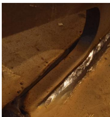
写真-付 2.2 パス間温度 100℃以下（溶接外観）
