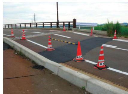
図-6.1.17 背面段差の補修
