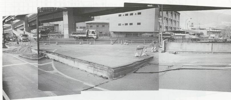
写真 1.2.7.11 損傷状況(杭) Photo. 1.2.7.11 Damage on piles
