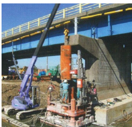
図-5.3.2 中掘り杭工法による桁下施工例 9)
