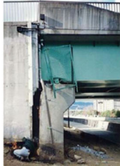
① 桁端部の損傷
