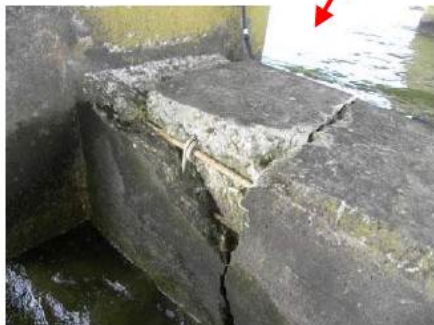
写真-3.7.1.6 2柱式ラーメン橋脚の損傷(P51橋脚)
