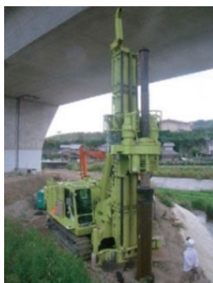
図-5.3.1 回転杭工法による桁下施工例 8)
