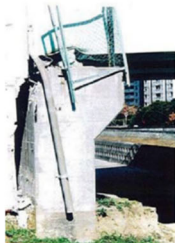
① 桁端部の損傷
