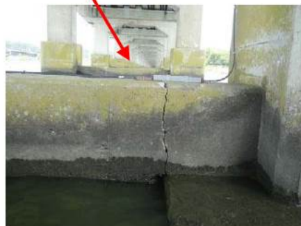
写真-3.7.1.6 2柱式ラーメン橋脚の損傷(P51橋脚)
