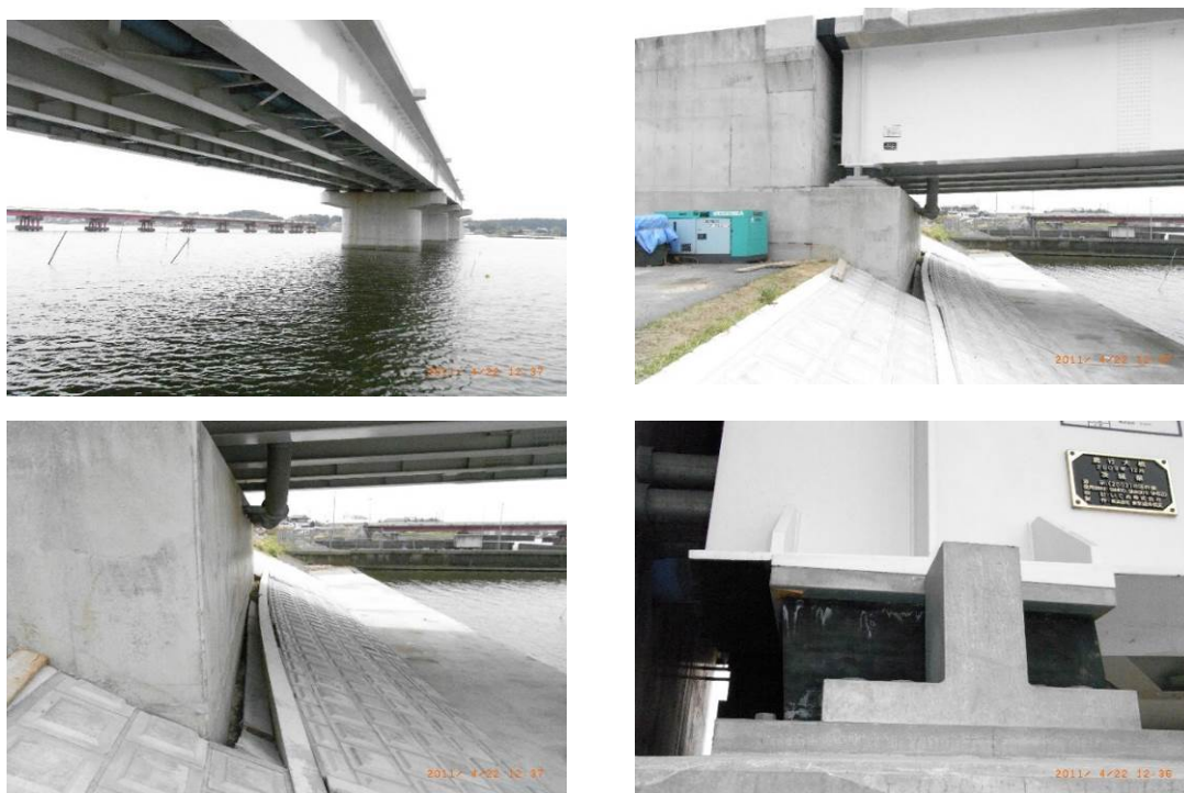
図-1.1.7 2011年3月11日東北地方太平洋沖地震で周辺地盤の流動化による下部構造の移動とそれに起因する積層ゴム系支承の残留変形
