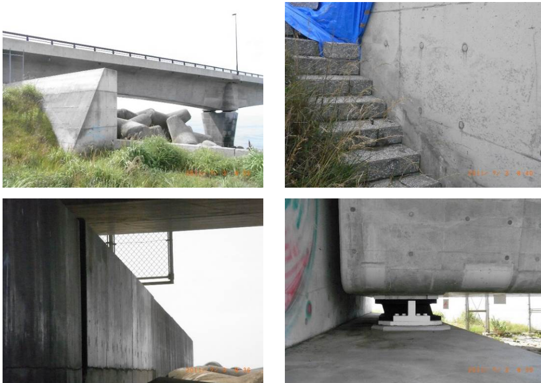
図-1.1.7 2011年3月11日東北地方太平洋沖地震で周辺地盤の流動化による下部構造の移動とそれに起因する積層ゴム系支承の残留変形
