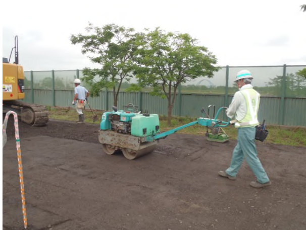
写真-1 転圧状況
