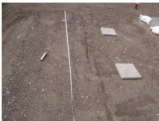
写真-2 盛土天端の状況 (H29. 8. 4 撮影)
