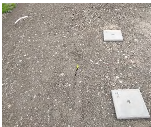
写真-3 盛土天端の状況 (H30. 6. 7 撮影)
