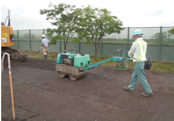
写真-1 転圧状況
