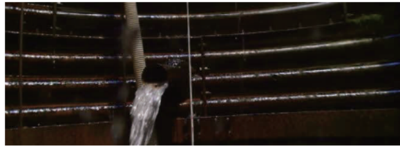
(b) 深さ 9.0m 集水管の閉塞状況
