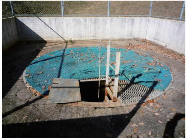
図9 エキスパンドメタル製の天蓋 (落ち葉等の侵入防止のため天蓋にネットをかけている)
