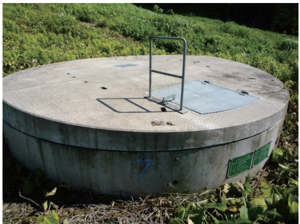
図11 コンクリート製の天蓋
