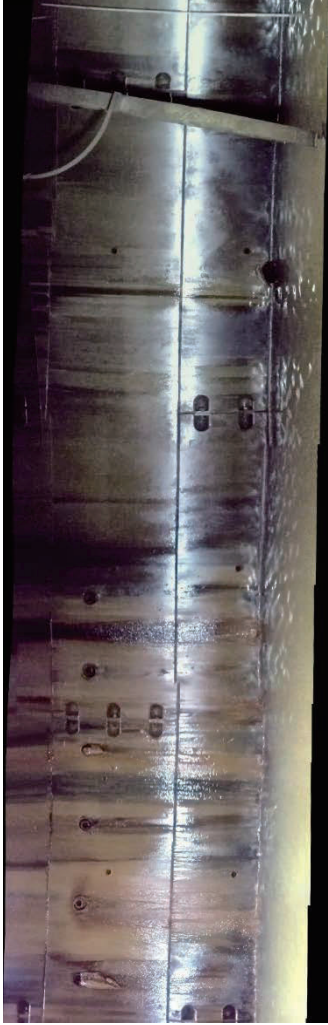
集水ボーリングと排水ボーリングの状況 (中栗地すべり防止区域：新潟県土木部提供)
