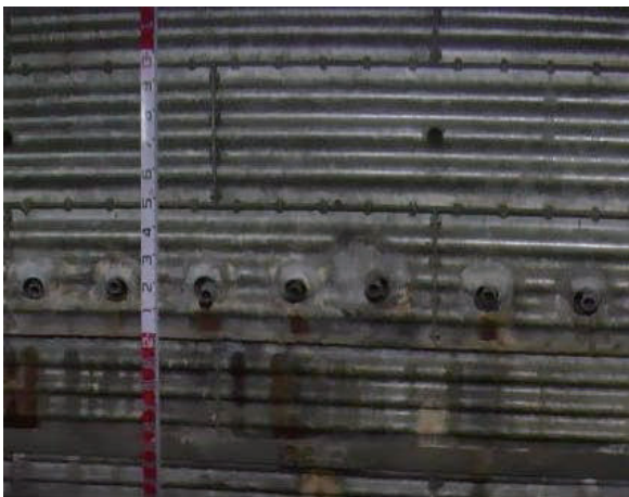
集水管の状況
