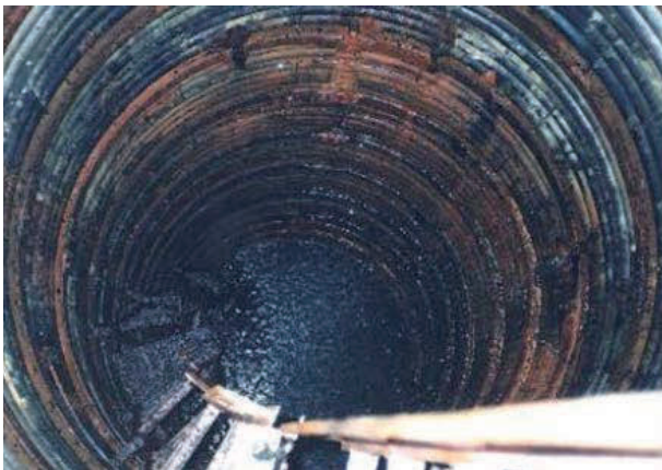
図1 井筒の腐食 15)
