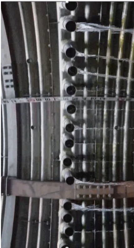
集水ボーリングの排水状況 (国土交通省北陸地方整備局提供)
