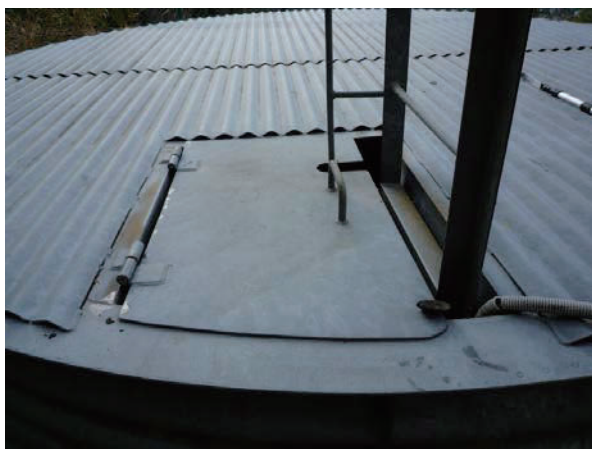
図12 天蓋に設けられた出入口
