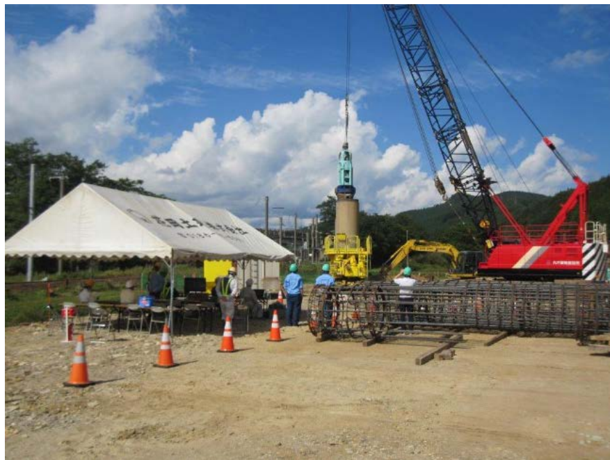
写 2. 4. 4 掘削状況 (A2-7)
