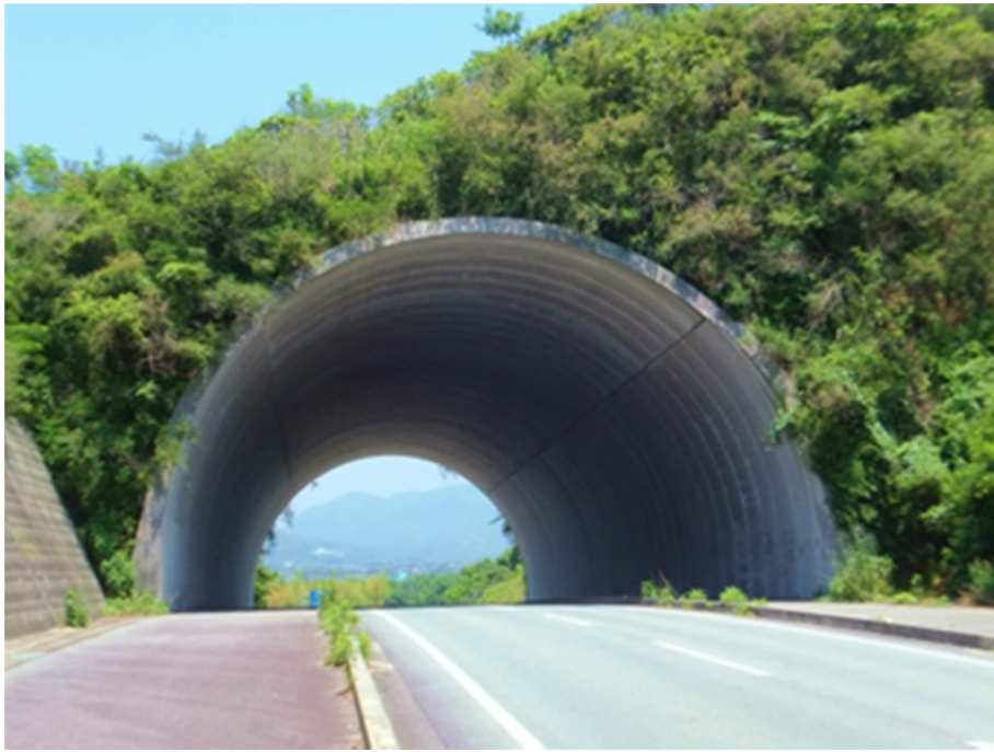
写真-2.6 調査時の断面状況写真
