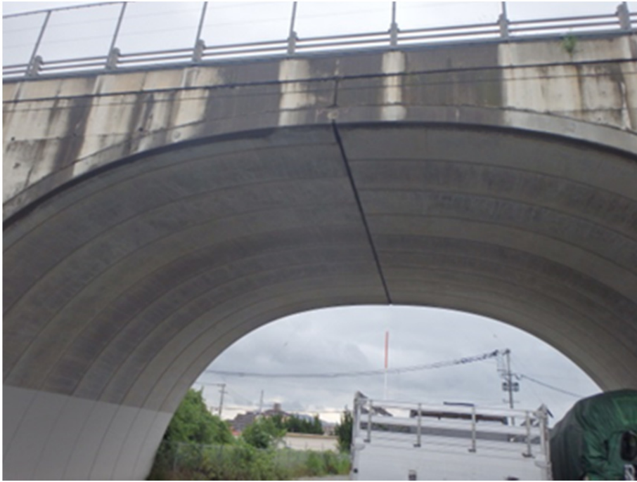
写真-2.16 クラウンでのヒンジの開き
