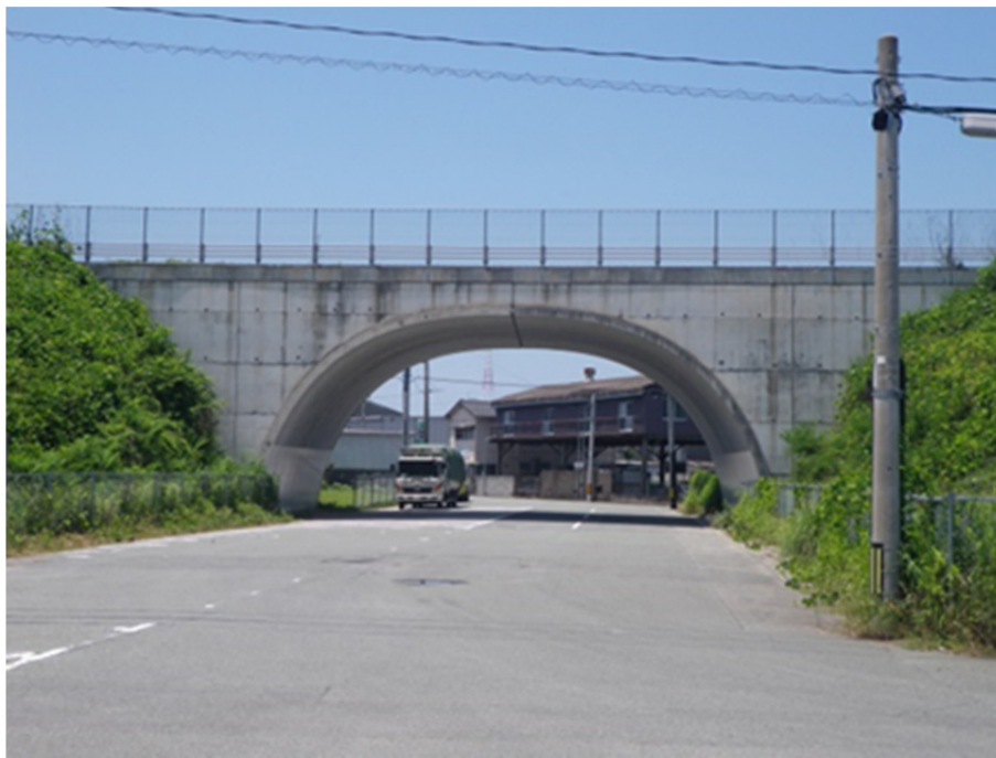
写真-2.15 調査時の断面状況写真
