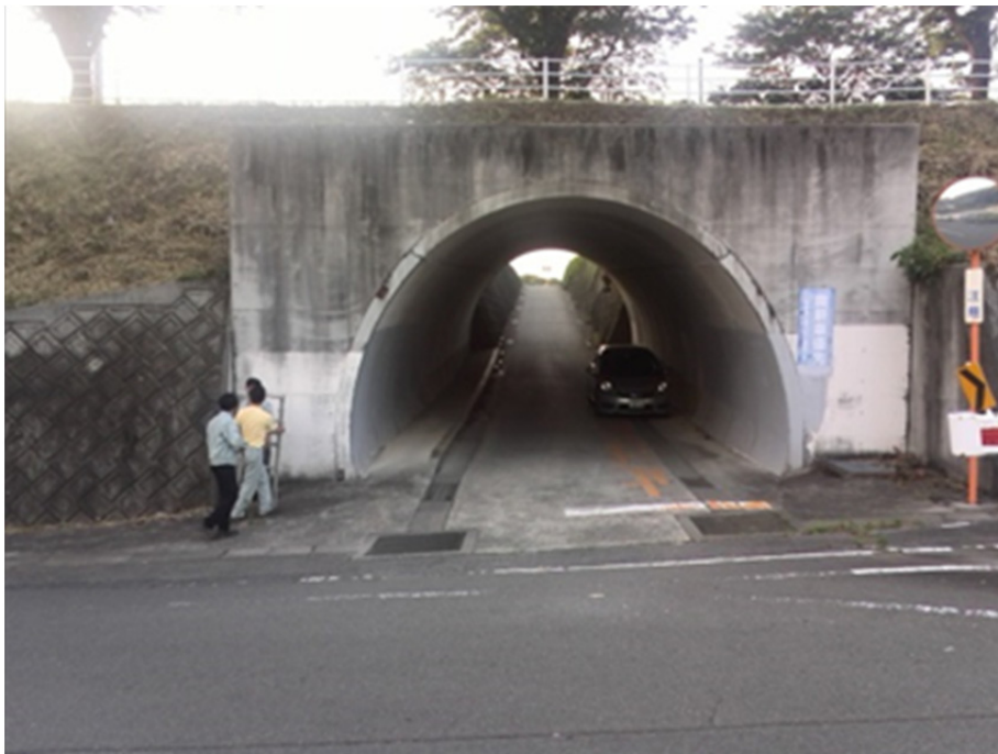
写真-2.1 調査時の断面状況写真
