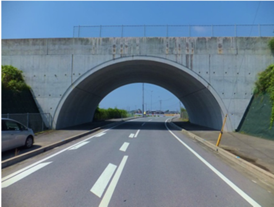
写真-2.9 調査時の断面状況写真
