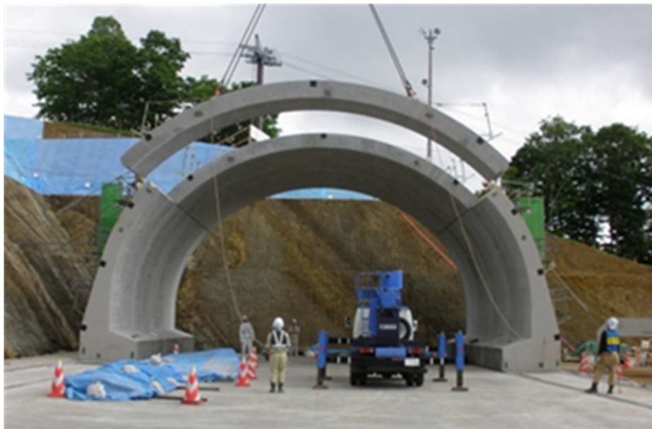
(b) 施工状況
