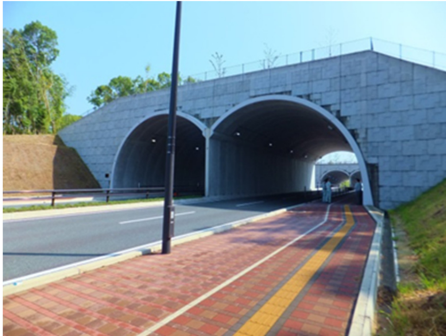
写真-2.12 調査時の断面状況写真
