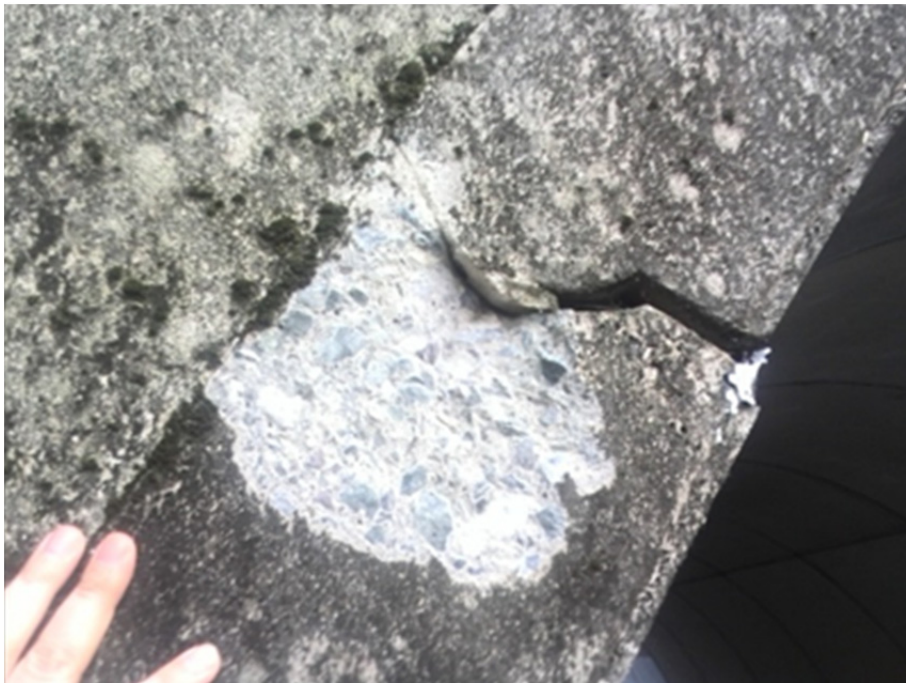
写真-2.3 ヒンジ部間隙へのモルタル注入跡
