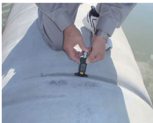
写真 2.1.15 デプスゲージによるひび割れ深さ計測
