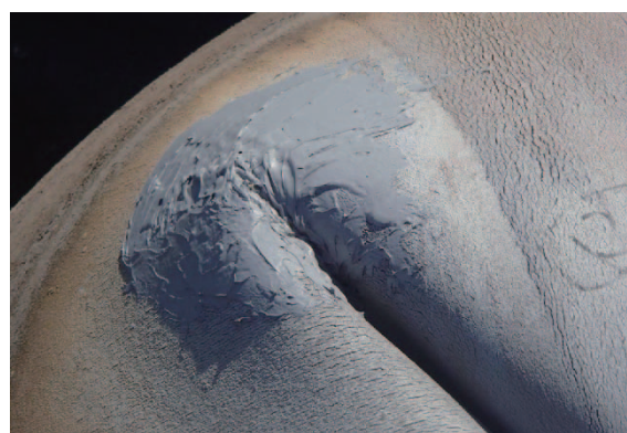
写真 2.1.14 同左 (ひび割れ部にコーキング剤塗布)
