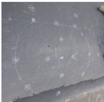
写真 3.1.7 ゴム堰上部外観
