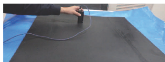
写真 3.1.4 打音測定状況
