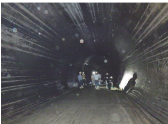
写真 3.1.5 ゴム堰内部状況
