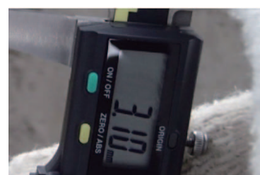
写真2.1.24 亀裂深さ ; 3.1mm
