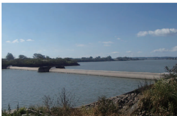
写真 2.1.11 起立状況 (上流側→下流側)
