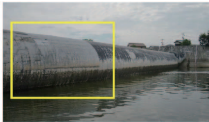
写真 2.2.15 延命補修事例
