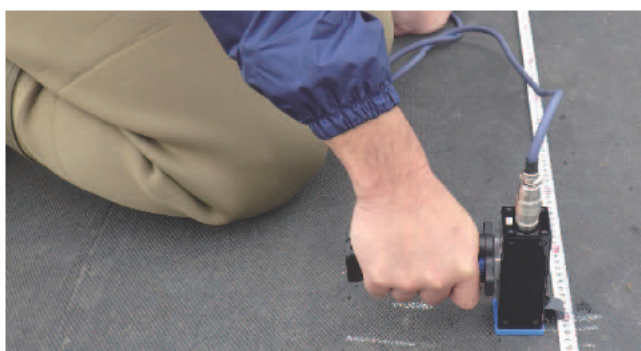
写真 3.1.9 ゴム堰上部打音測定状況
