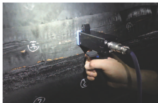
写真 3.1.10 ゴム堰内部側面打音測定状況
