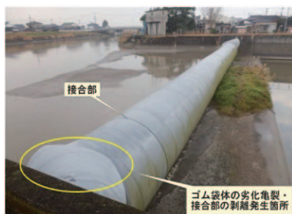
写真 2.2.11 ゴム袋体の構造(接合部,法部(○部))
