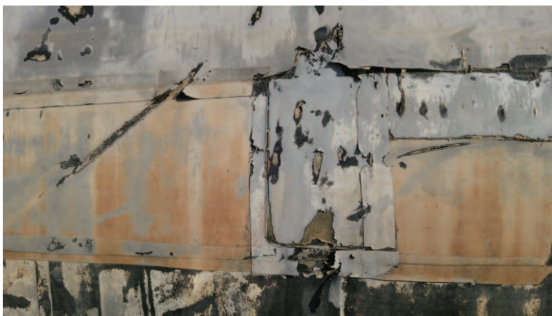
写真 2.1.1 転石摩耗による劣化状態
