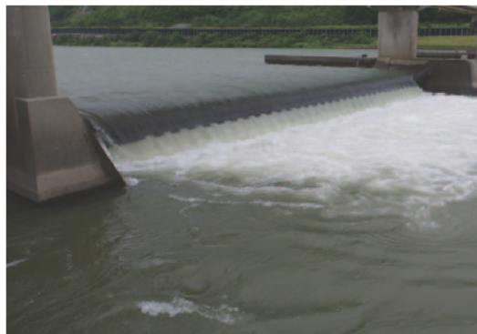
写真 2.1.10 堰体振動した堰の例
