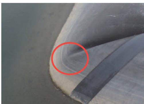
写真 4.1.2 法尻の折れジワ頂点
