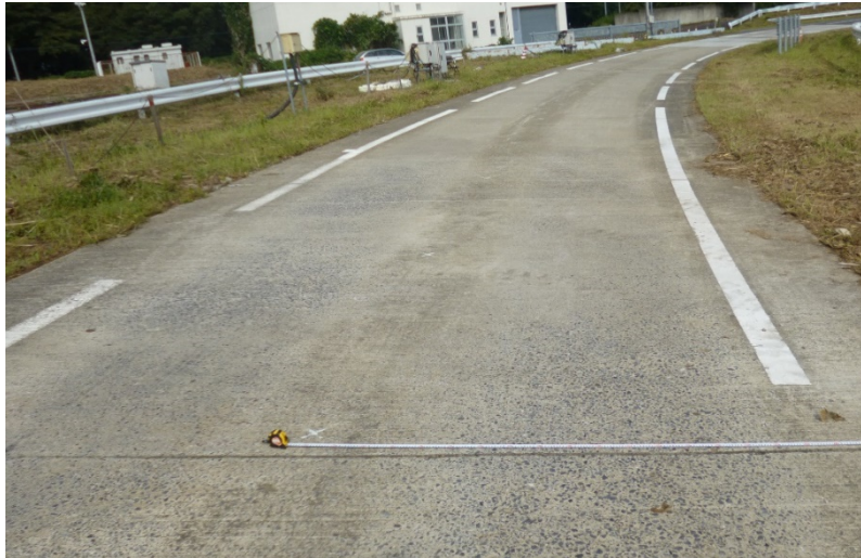
写真-3.2.5 舗装走行実験場のコンクリート舗装版工区
