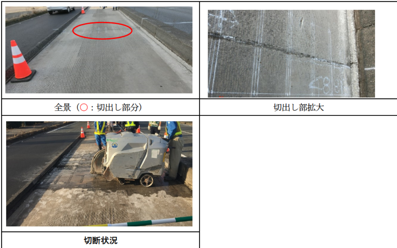
写真-2.2.1 コンクリート版の切出し箇所 (目地①)
