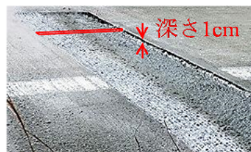
写真-9.2.2 模擬段差
