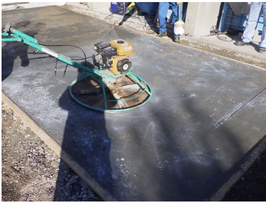
写真-4.3.7 工区1 打設後の饅ならし状況
