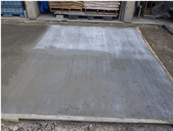
写真-3.3.6 工区1 ほうき目仕上げ後の状況
