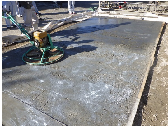
写真-4.3.6 LMFC®打設後の全景
