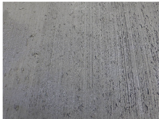
写真-3.3.7 工区2 ほうき目仕上げ後の状況
