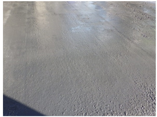
写真-4.3.9 工区2 初期養生剤散布後の状況
