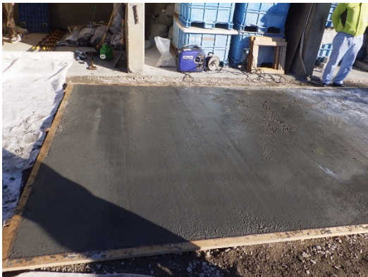
写真-4.3.9 工区2 初期養生剤散布後の状況
