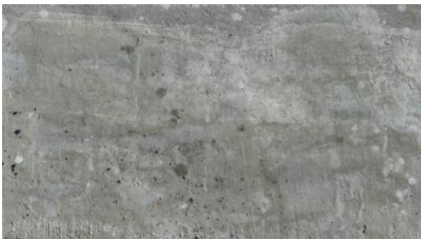
区画1 粗面仕上げ無し
