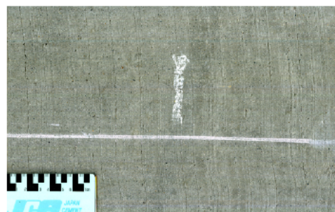
写真-2.4.3 配合 No. 1, 提案工法 1, OWP
