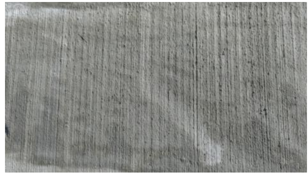
区画4 再こて仕上げ
