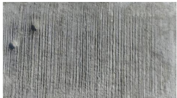
区画4 再こて仕上げ
