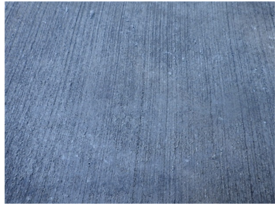
写真-3.3.6 工区1 ほうき目仕上げ後の状況
