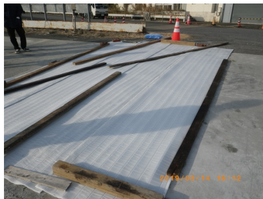
写真-2.6.6 養生マットの敷設状況
