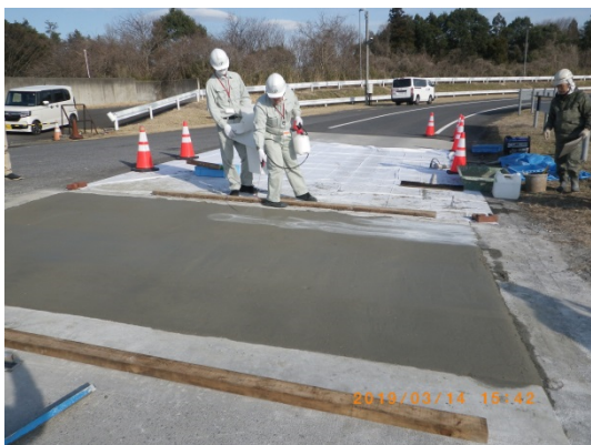
写真-2.6.5 養生剤の散布状況
