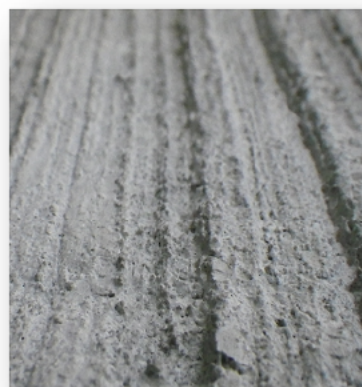
(2) 遅めに粗面仕上げを行った例 (テクスチャが適切に形成されている)
