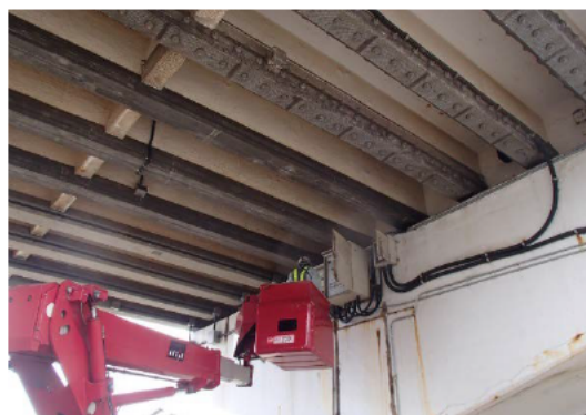
写真-2.5.6 高所作業車による調査状況
