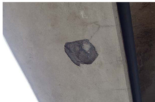
写真-2.5.1 チタンメッシュ方式陽極被覆モルタル剥落部（G1 桁底面）
