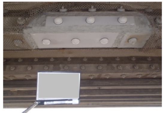
写真-4.5.4 代替防食板設置完了
