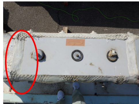
写真-5.5.4.2 建研式試験箇所詳細
