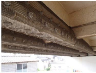
図-3.1.4 流電陽極方式の概要
