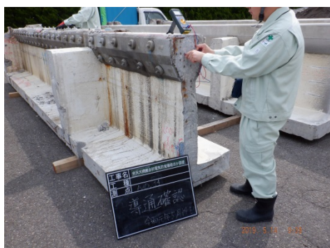
写真-5.5.2.1 導通確認状況
