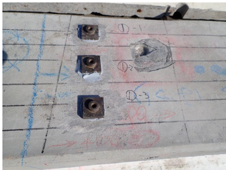
写真-5.3.3.1 付着試験用治具接着状況
