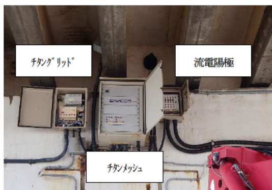
写真-2.5.3 直流電源装置および流電モニタリングボックス
