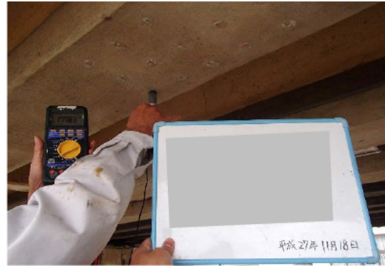
写真-3.3.22 チタンメッシュ健全部測定状況
