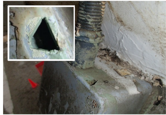
写真-3.3.16 チタングリッド方式（樹脂充填）
