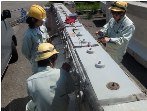
写真-5.5.2.5 表面電位測定状況
