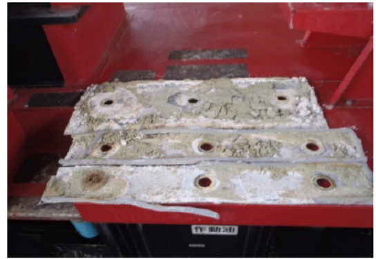
写真-4.5.2 亜鉛防食板撤去完了
