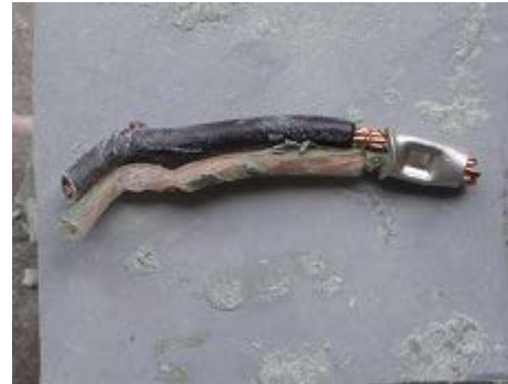
写真-5.4.5.4 排流端子と電線の結線
