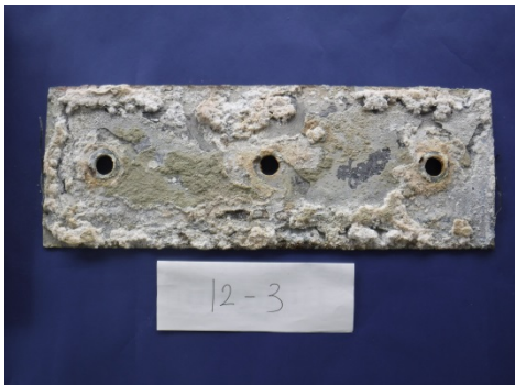
写真-5.5.3.17 陽極撤去後 12-3
