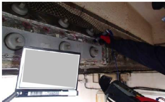
写真-4.5.5 既設防食板周囲オン電位測定
