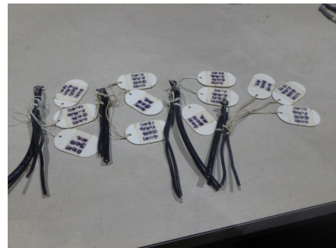
写真-5.5.5.2 養生撤去後
