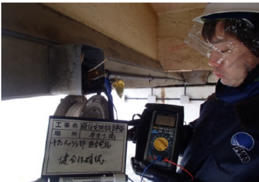
写真-4.6.2 電位値確認状況
