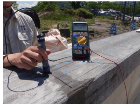
写真-5.4.2.4 表面電位測定状況
