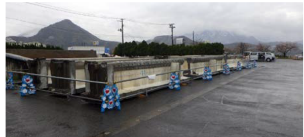
写真-5.2.2 調査桁配置状況
