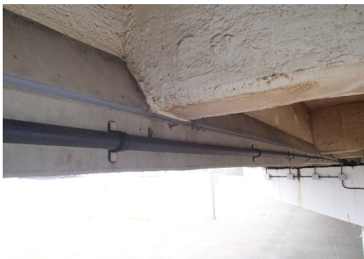
写真-3.3.11 チタンメッシュ方式 (直線部配管状況)
