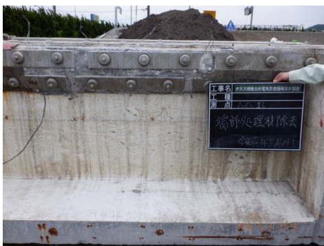
写真-5.5.2.3 間詰パテ撤去後ブロック⑪
