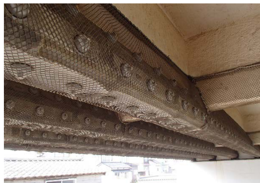
写真-2.5.2 流電陽極方式部養生ネット設置状況（G8～G11 桁）
