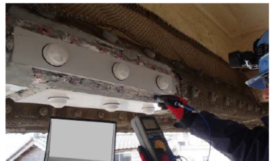
写真-4.5.6 代替防食板周囲オン電位測定
