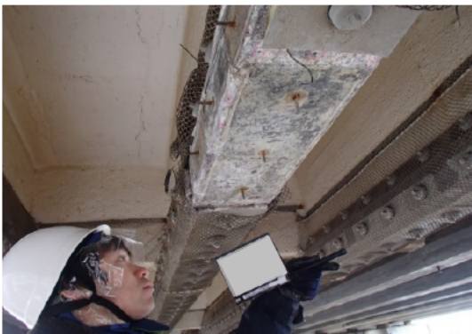
写真-4.5.3 コンクリート表面確認
