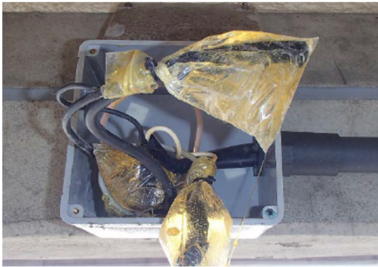
写真-3.3.15 チタンメッシュ方式結線部
