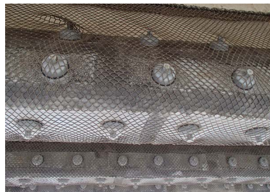
写真-2.5.2 流電陽極方式部養生ネット設置状況（G8～G11 桁）
