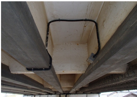
写真-3.3.13 チタングリッド方式 (桁横断部配管状況)
