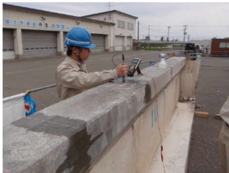
写真-5.4.2.3 表面電位測定状況
