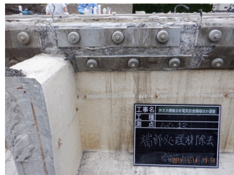
写真-5.5.2.4 間詰パテ撤去後ブロック⑫
