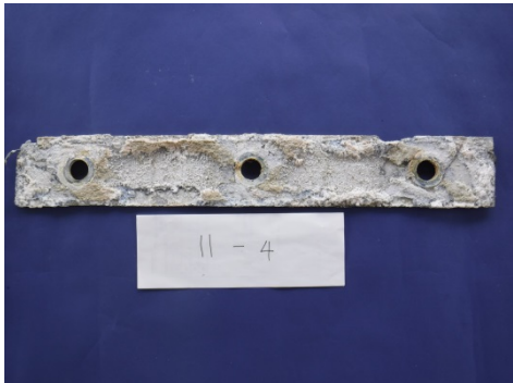
写真-5.5.3.9 陽極撤去後 11-4
