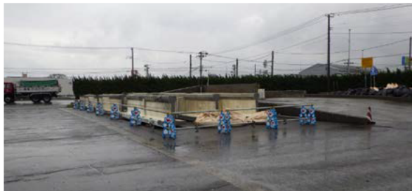
写真-5.2.1 調査桁配置状況
