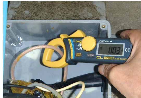
写真-3.3.24 電流測定状況
