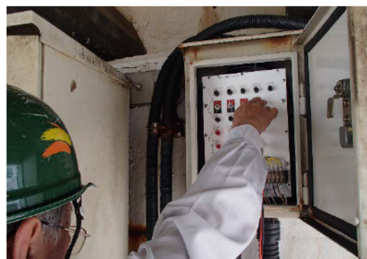
写真-2.5.3 直流電源装置および流電モニタリングボックス
