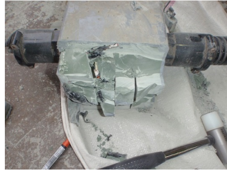
写真-5.4.5.2 プルボックスの解体状況
