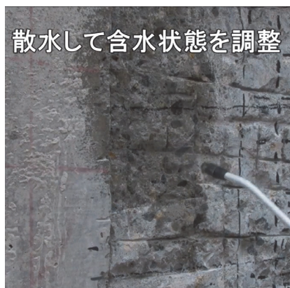
図3-2 はつり面での含水状態の調整の例
