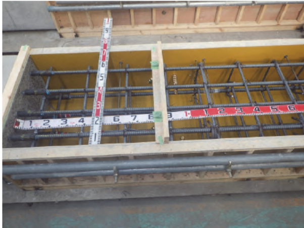
a) 配筋状況
