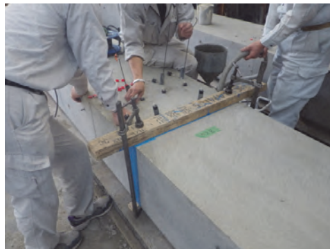
d) グラウト充填状況
