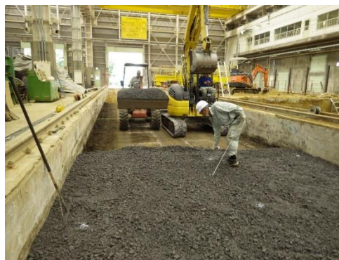
a) まき出し、敷き均し状況
