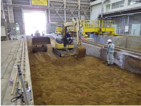
a) まき出し、敷き均し状況
