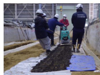
(前後進コンパクタによる締固め)
