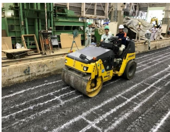
付図 F-4 路盤の転圧状況
