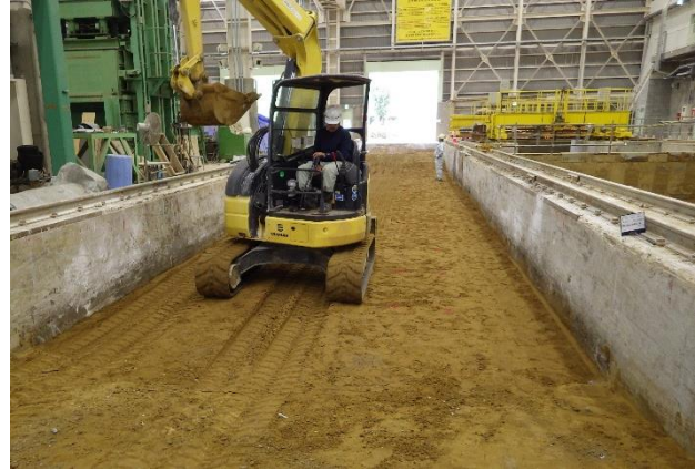
b) 整地状況 (転圧0回)
