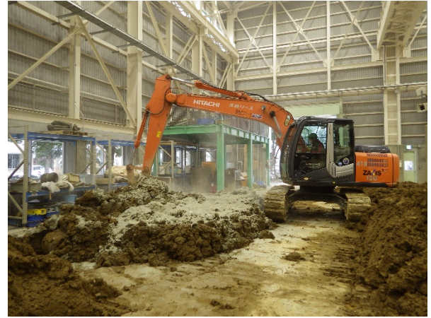
(b) 美浦砂とセメント系固化材の攪拌混合
