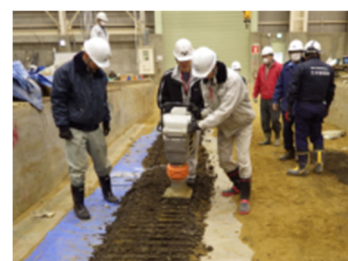
(ランマによる締固め)
