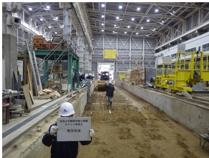
図 7.2-7 締固め機械による締固め状況 (美浦砂改良土)
