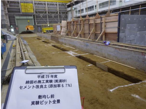
図 7.3-4 試料投入前の実験溝 (美浦砂及び美浦砂改良土)
