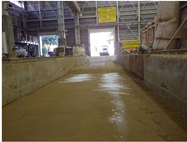
図 7.2-5 試料投入前の実験区間 (美浦砂改良土)
