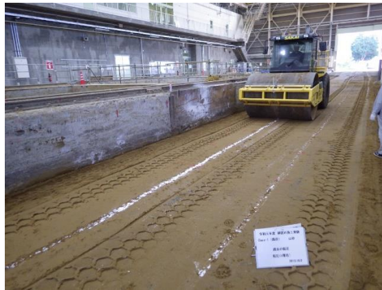
付図 E-5 山砂の転圧状況 (2層目)
