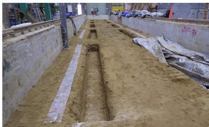
図 8.2-6 試料投入前の実験溝（仮置土及び仮置土改良土）
