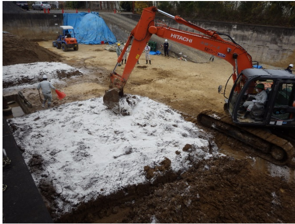
(a) 美浦砂と生石灰の攪拌混合
