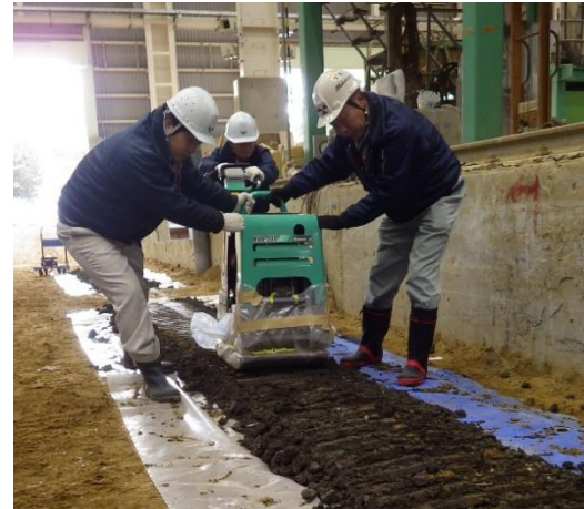
(b) 前後進コンパクタによる締固め状況
