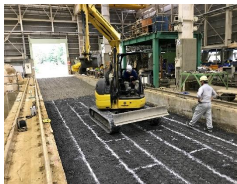
b) 整地状況 (転圧0回)
