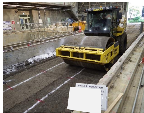
2) 振動ローラによる転圧
