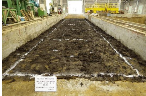
1) 仮置土 敷き均し (層厚 50 cm)
