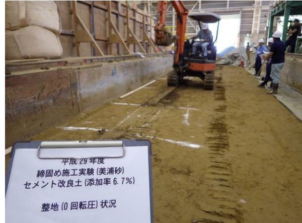
図 7.3-5 試料の整地状況 (美浦砂及び美浦砂改良土)
