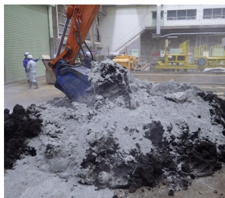
b) セメント改良土における混合状況
