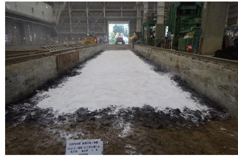
2) 改良材散布 (生石灰の例)
