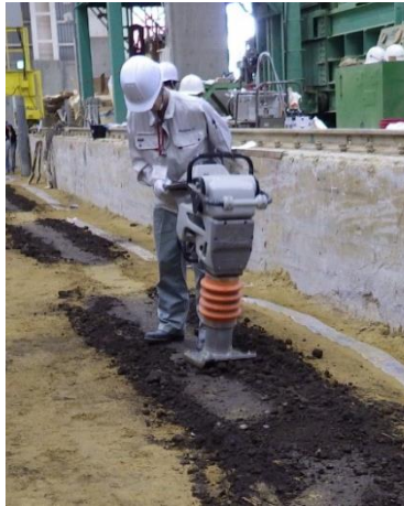
(a) ランマによる締固め状況
