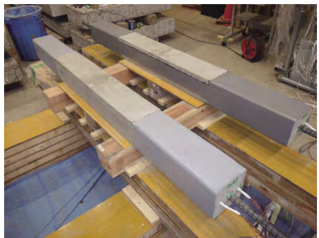
(d) パテの施工
