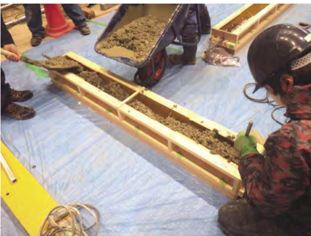
図-2.3.6 コンクリートの打設
