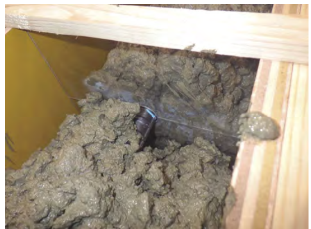
図-2.3.7 打設時のスリット周辺
