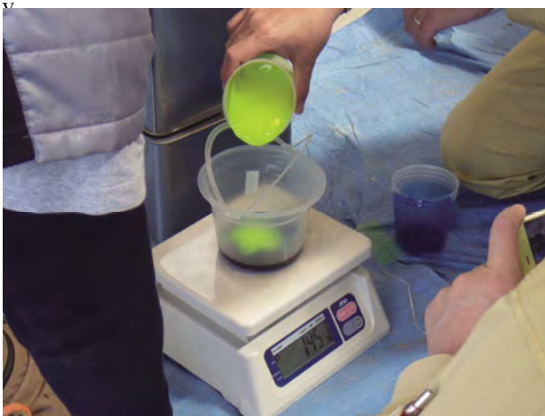
(c) 樹脂材料の施工量管理
