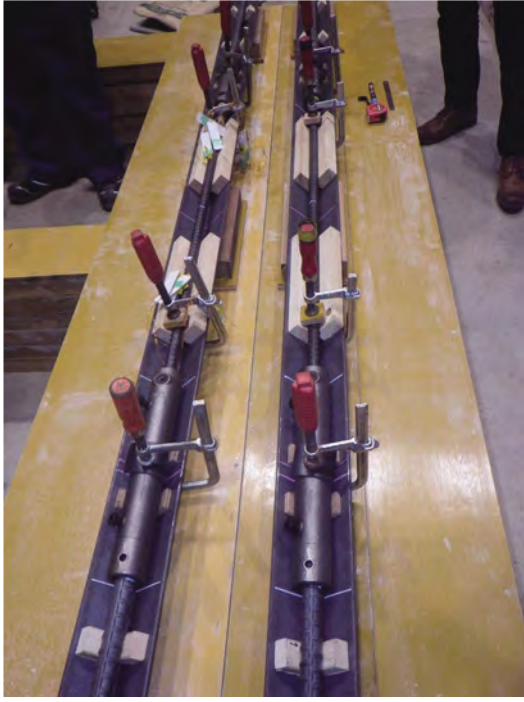
図-2.2.7 鉄筋とスリーブの心出し調整
