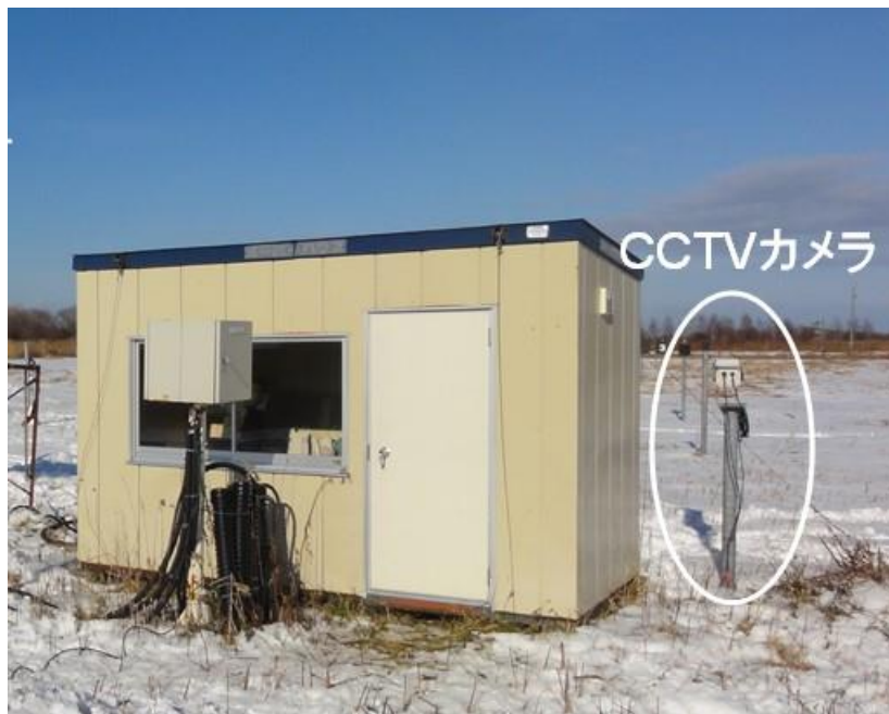
図-2 CCTV カメラの設置状況
