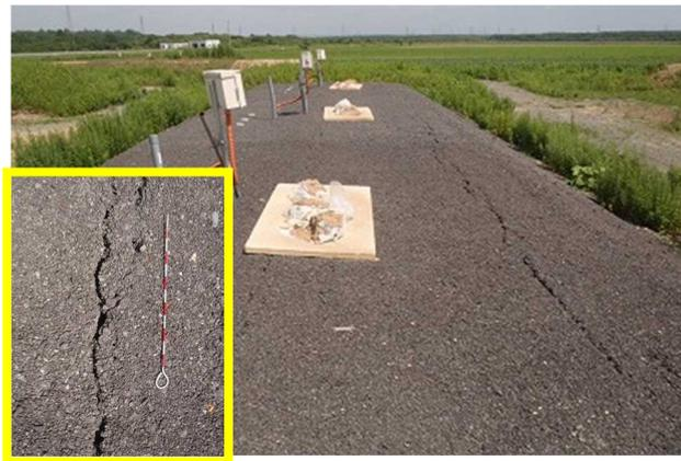
写真-3 盛土天端に発生したひび割れ
