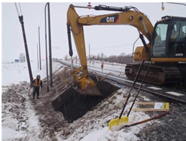
写真-4 アスファルト廃材ののり面への施工
