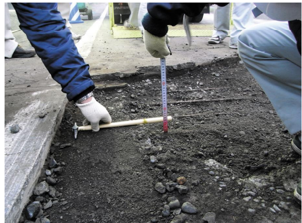
写真-1 寒冷地の土砂化の事例
