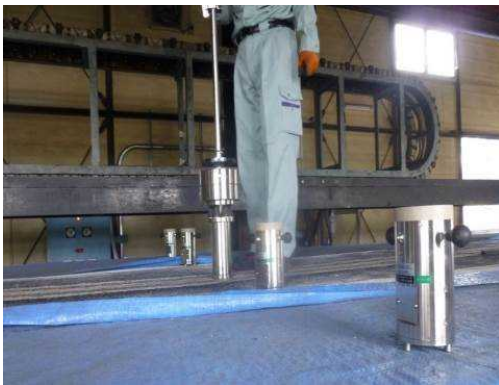
写真 2-2 小型 FWD 試験状況
