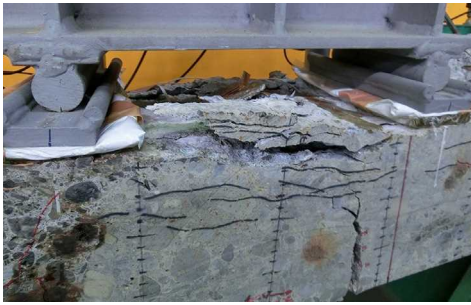
写真4 試験体中央上縁の損傷状況 (SS01)
