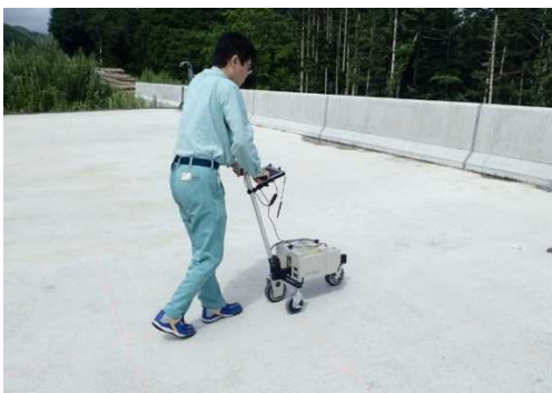
写真 2-1 牽引式路面性状測定装置による表面形状の測定状況
