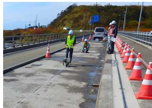
写真-1 床版面形状の測定状況
