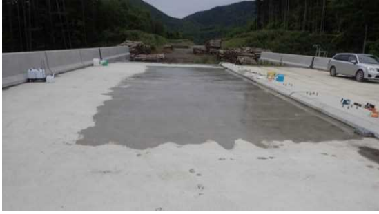
写真-2 散水状況
