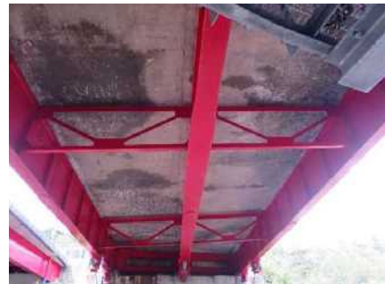
写真-1 床版下面の状況
