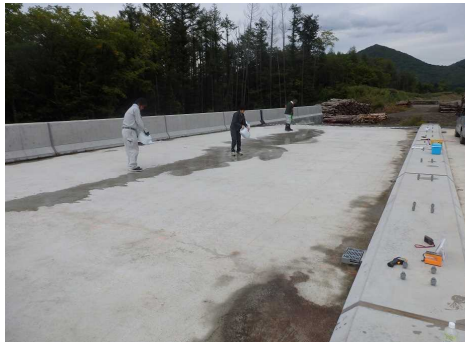
写真-2 散水試験の状況
