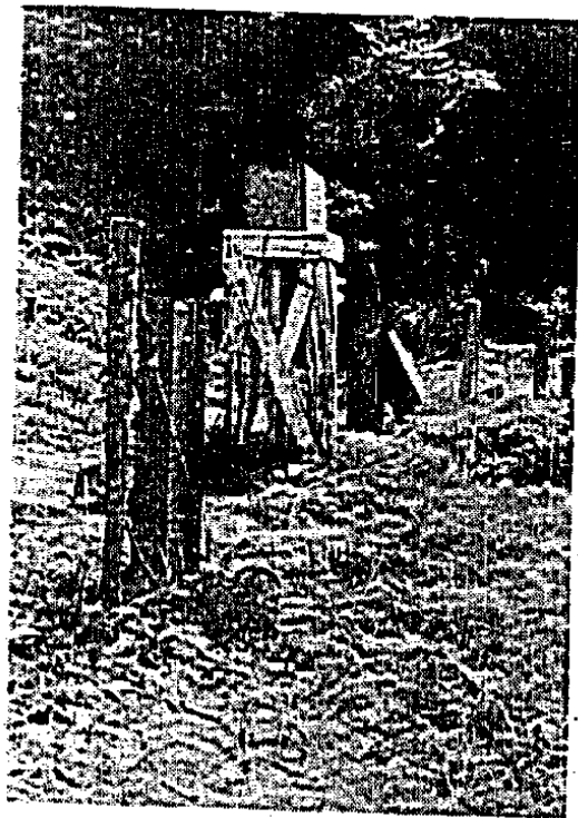
手前は単杭 向側は合掌杭 (昭和38年11月)
