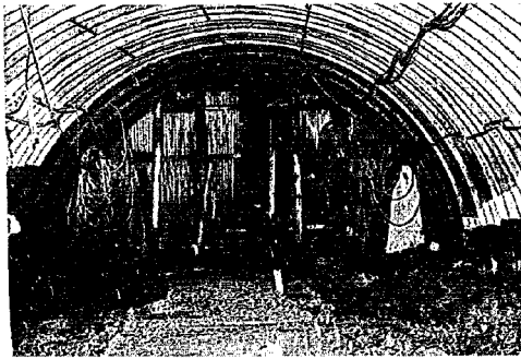
完成後の坑口
