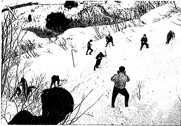
写真-4-7 斜面での装薬作業
