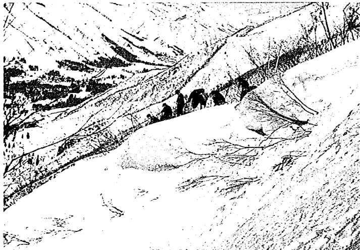
写真-4-6 雪庇の装薬作業（土樽）
