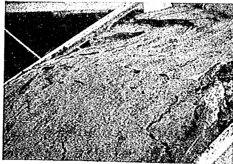
写真-5.11-② 斜面 間部の盛り上がりとそのクラックの発先
