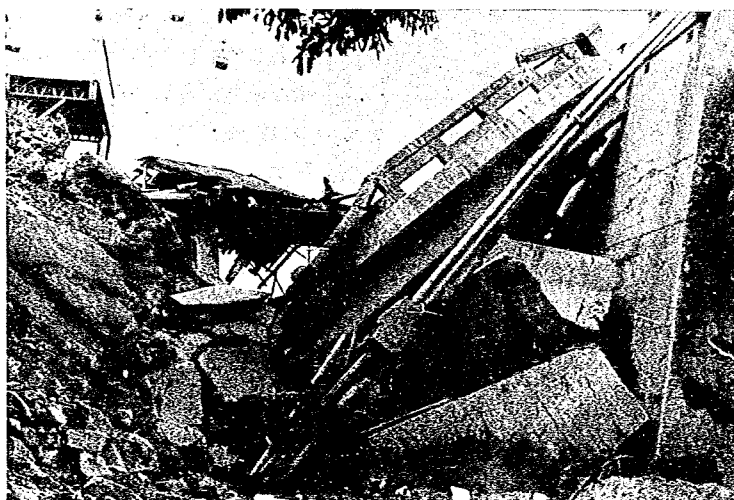
写真-1.6 土石流で破壊された橋
