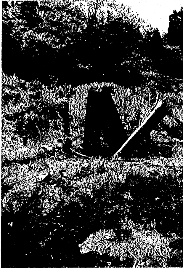
写真-21 溶接部分がはがれて垂直に挿入されたH型鋼管が傾斜して向きを変えている (昭和39.4)
