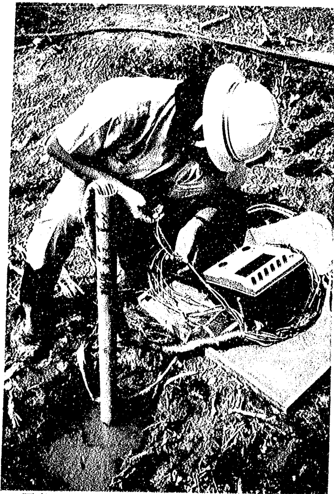
写真-16 パイプ歪計の測定 (昭和44年撮影)
