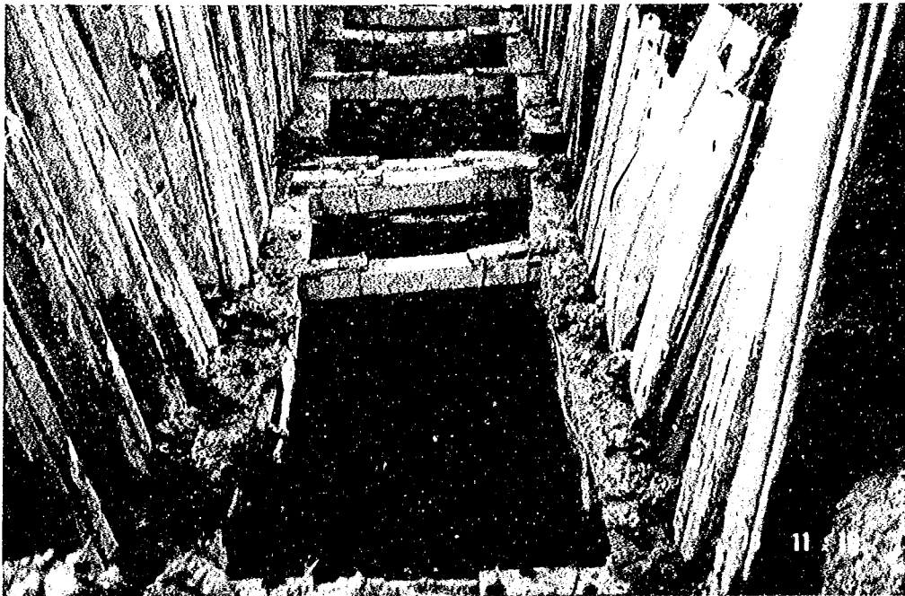
写真一18 しゃ水壁工施工中（昭和53年撮影）
