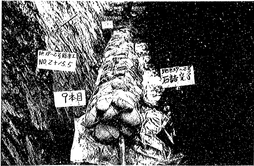
写真一17 暗渠工施工中（昭和50年撮影）
