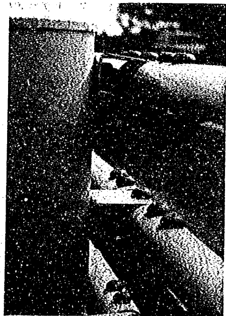
写真7.8 ガードパイプB種標準型 最上段ブラケットの前傾
