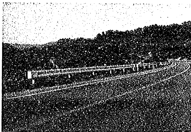
写真7.10 手の子地区ガードレール
