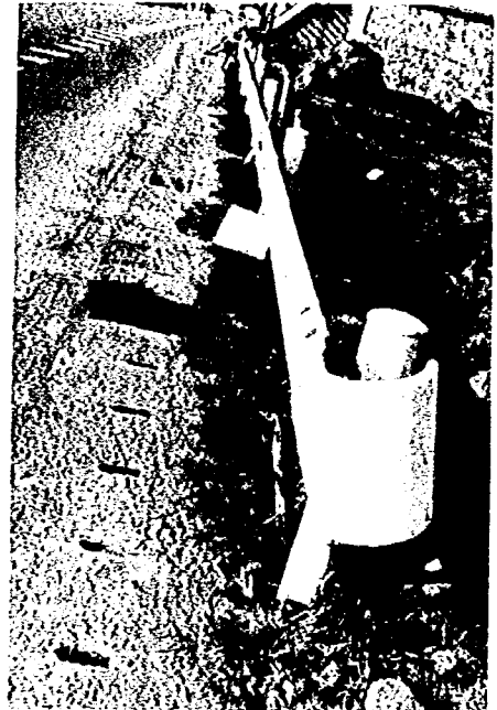
写真4-6 ガードレール A種 標準型(妙高村) 写真3のブラケット変形によるガードレールの前傾
