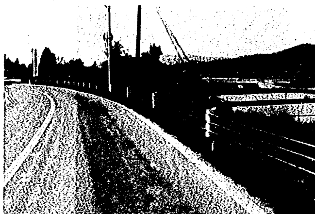
写真 4-12 ガードケーブル C種改良 I 型 最大荷重 398.6 kg 最大荷重深 145 cm ガードケーブル標準型、改良 II 型 最大荷重 563.6 kg 最大堆雪深 151 cm (下田村)
